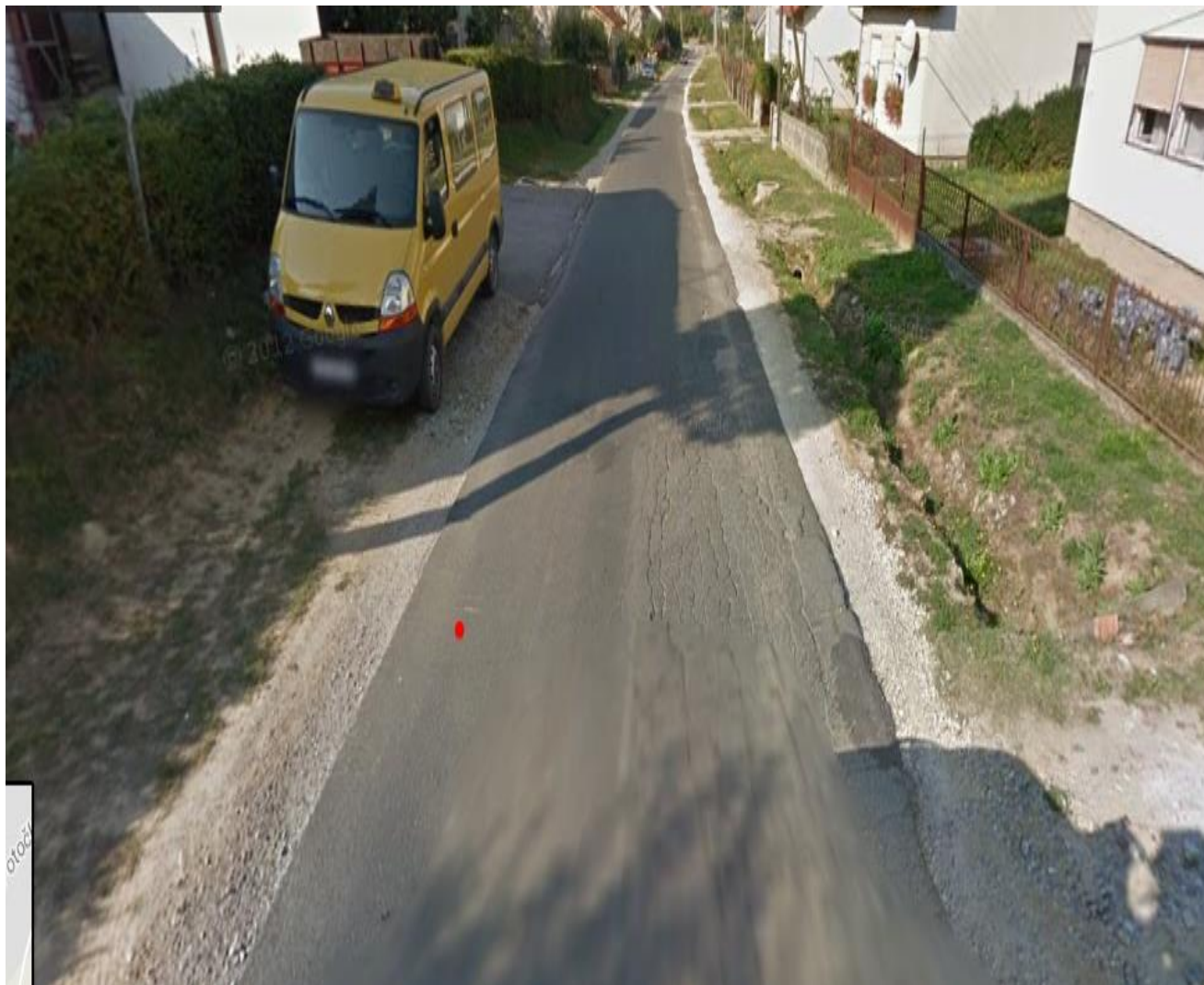
Slika 8. Dio kolnika na županijskoj cesti ŽC 2210 Veliki potočec – Križevci.
