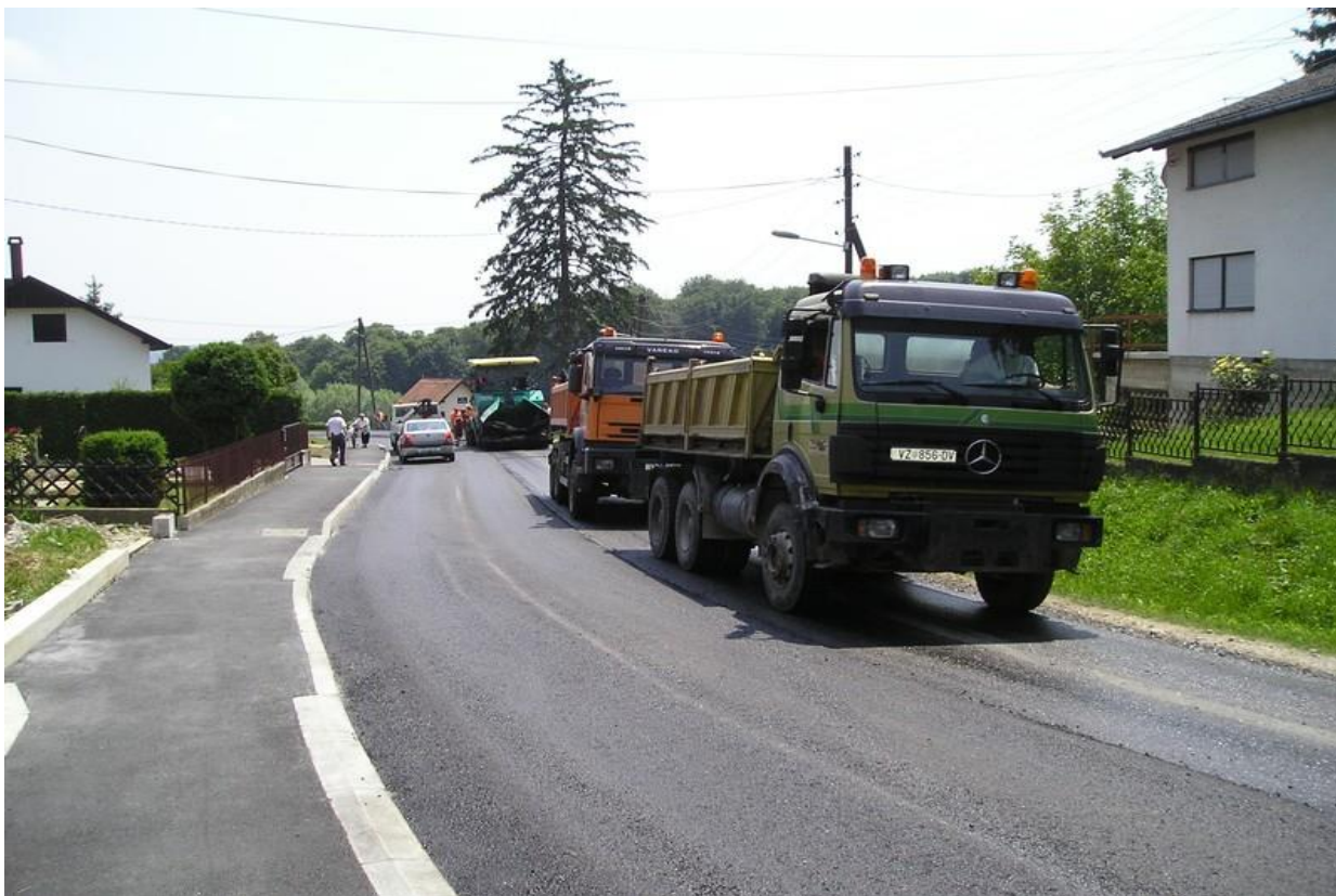
Slika 14. Rekonstrukcija kolničkog zastora i izgradnja nogostupa u Križevcima (Ul. kralja Petra Krešimira IV)
