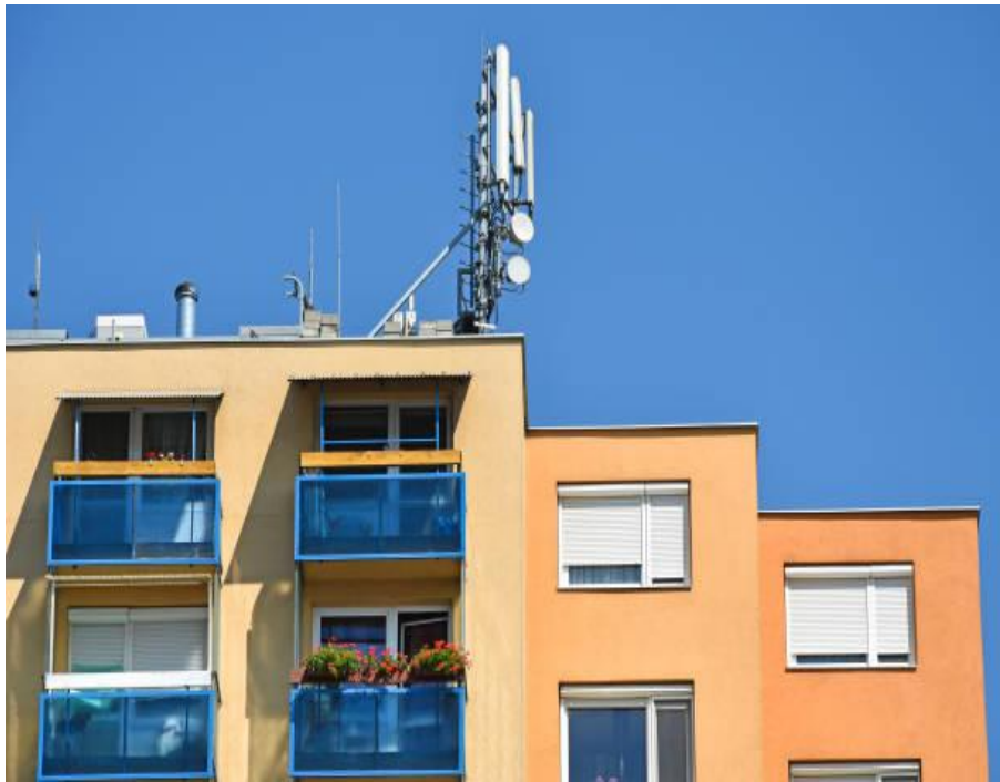
Slika 17: Prikaz tipične bazne stanice sa antenama koja se postavlja u naseljima, [37]
