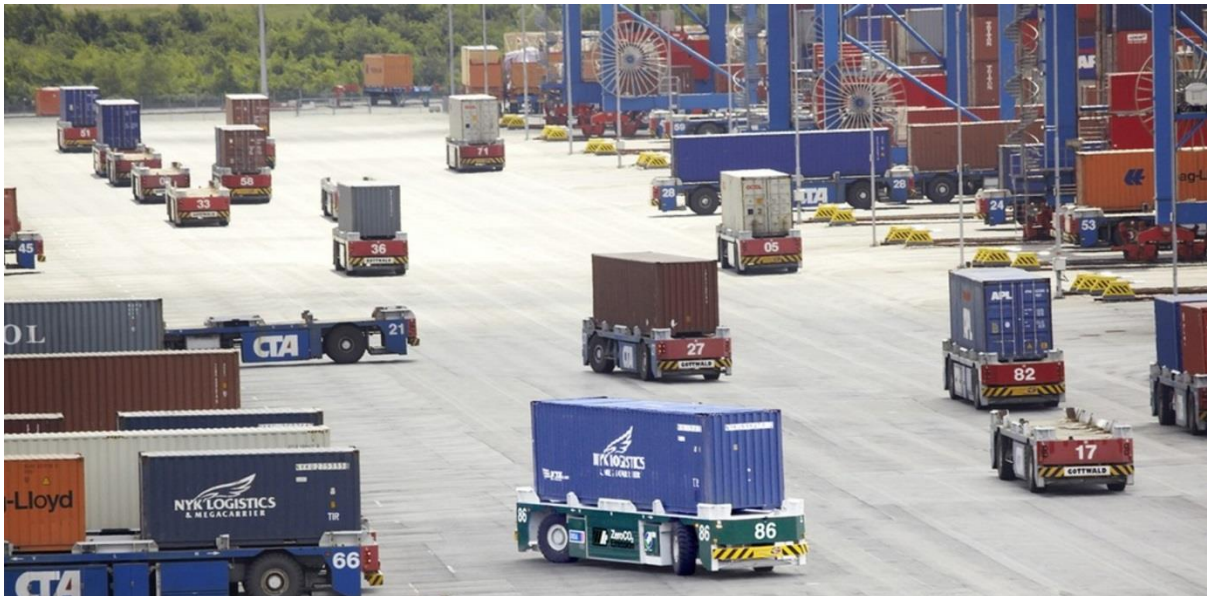
Slika 17. Automatizirani kontejnerski terminal Altenwerder (Hamburg)
