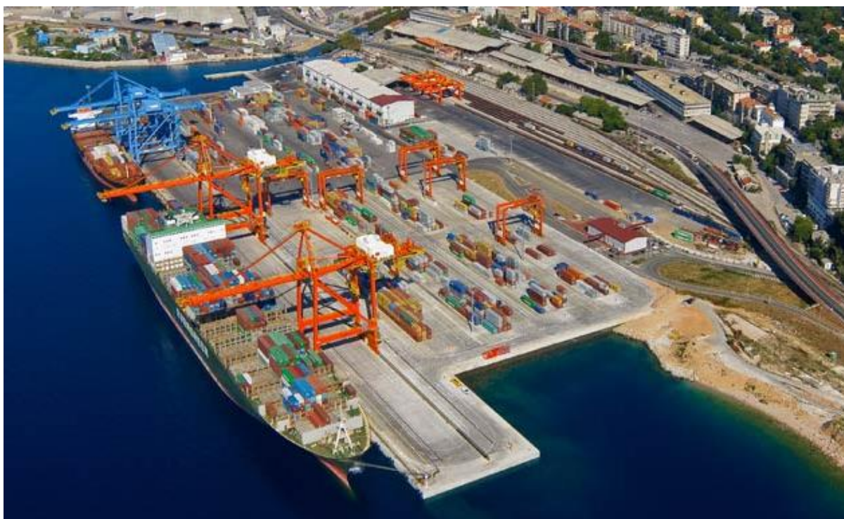
Slika 19. Kontejnerski terminal luke Rijeka (Brajdica)
