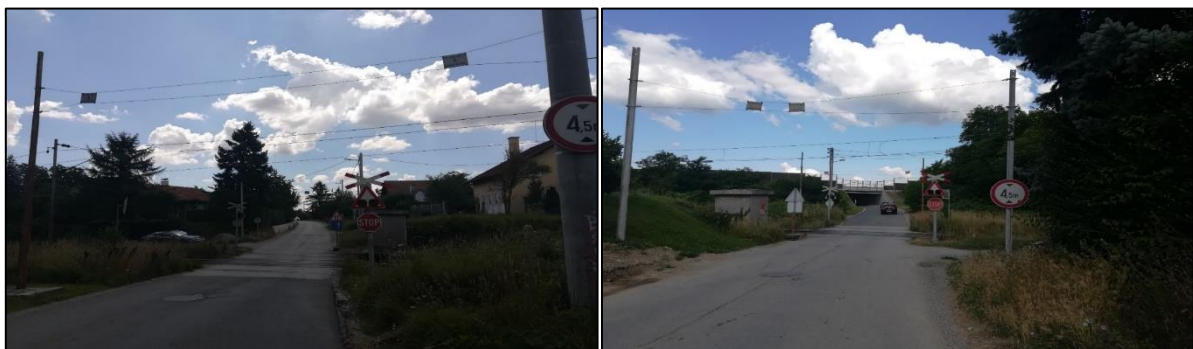
Slika 81. Željezničko-cestovni prijelaz „Demerje“ iz smjera sjevera Slika 82. Željezničko-cestovni prijelaz „Demerje“ iz smjera juga
