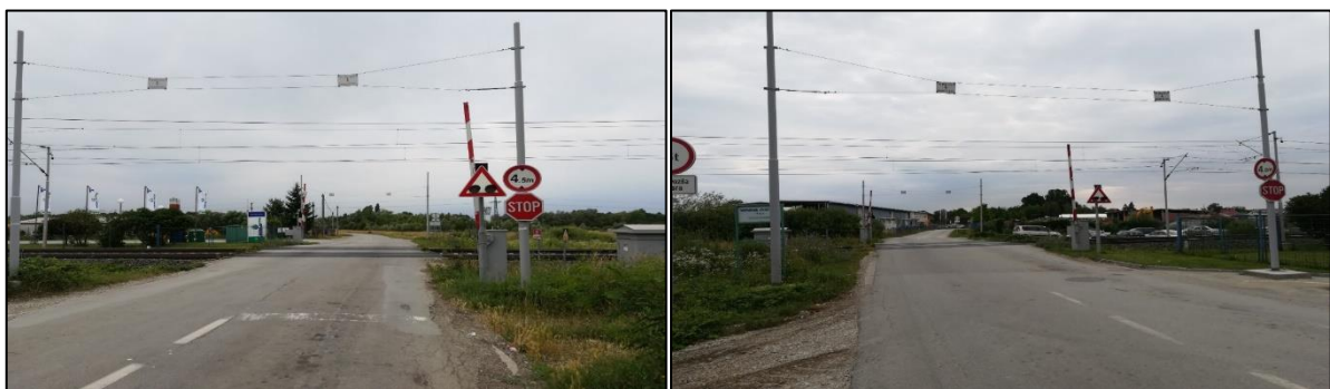
Slika 49. Željezničko-cestovni prijelaz „Staklana“ iz smjera sjevera Slika 50. Željezničko-cestovni prijelaz „Staklana“ iz smjera juga
