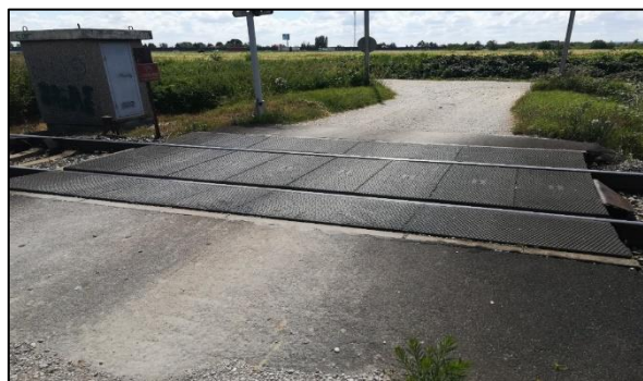
Slika 87. Prikaz stanja gumirane podloge na željezničko-cestovnom prijelazu „Žižići“
