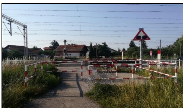
Slika 33. Željezničko-cestovni prijelaz „Treska“ iz smjera sjevera
