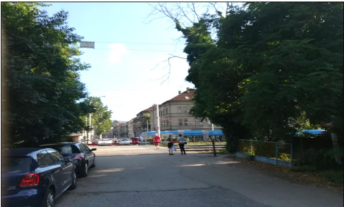
Slika 17. Željezničko-cestovni prijelaz „R. Austrije“ iz smjera juga
