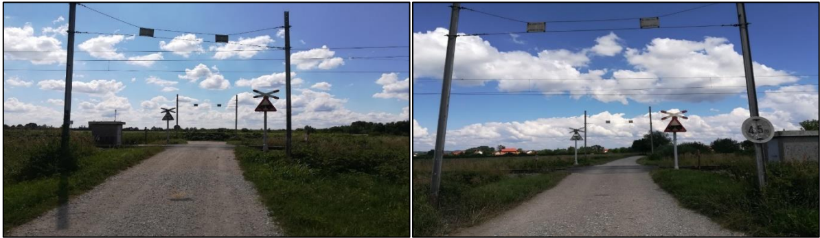
Slika 85. Željezničko-cestovni prijelaz „Žižići“ iz smjera sjevera Slika 86. Željezničko-cestovni prijelaz „Žižići“ iz smjera juga
