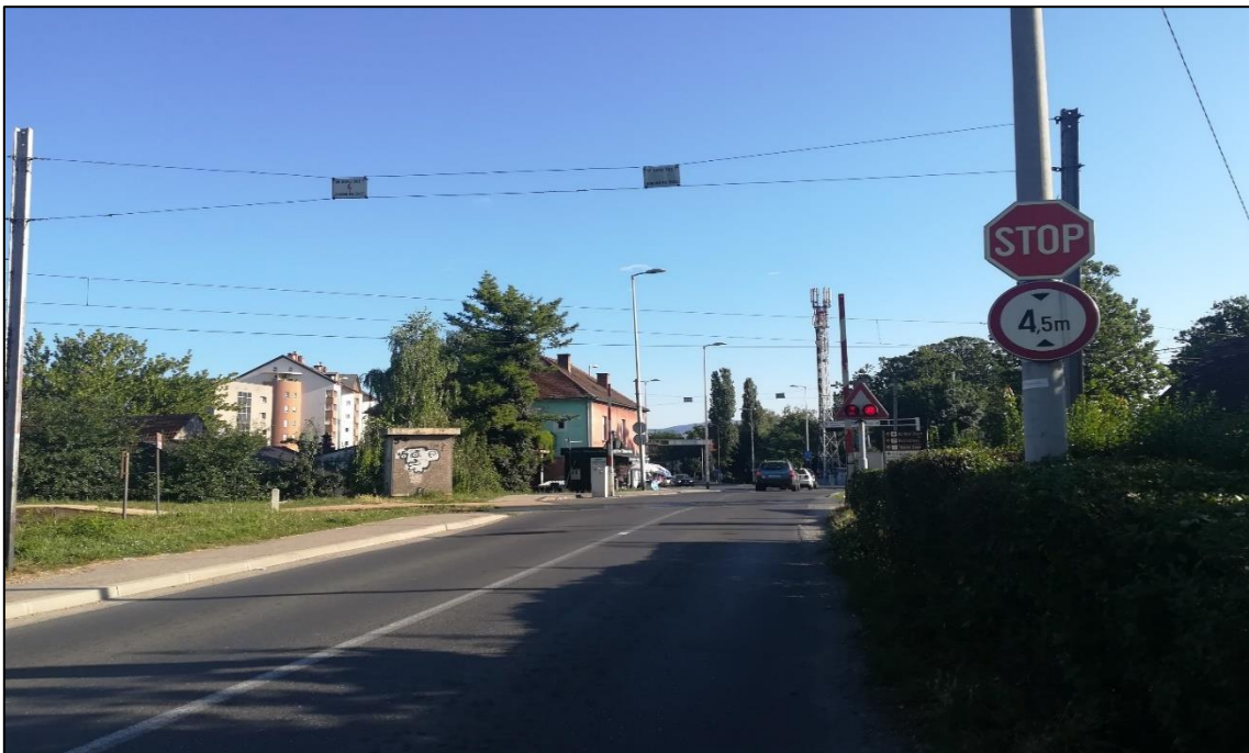
Slika 30. Željezničko-cestovni prijelaz „Remetinec“ iz smjera juga
