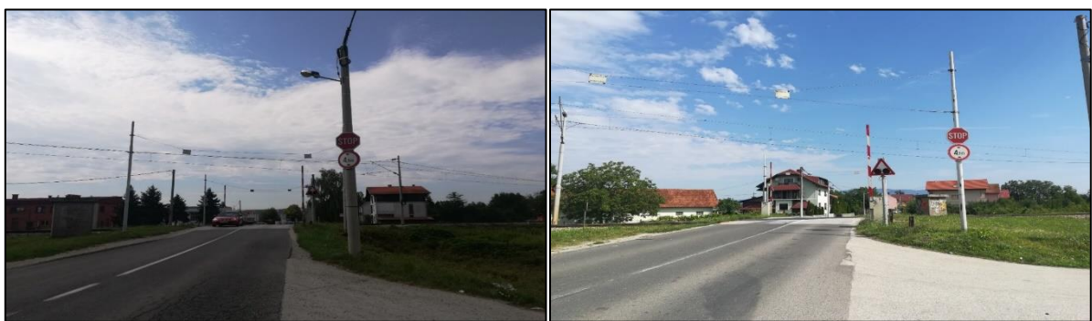
Slika 89. Željezničko-cestovni prijelaz „Brezovečka“ iz smjera sjevera Slika 90. Željezničko-cestovni prijelaz „Brezovečka“ iz smjera juga
