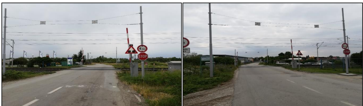
Slika 49. Željezničko-cestovni prijelaz „Staklana“ iz smjera sjevera Slika 50. Željezničko-cestovni prijelaz „Staklana“ iz smjera juga
