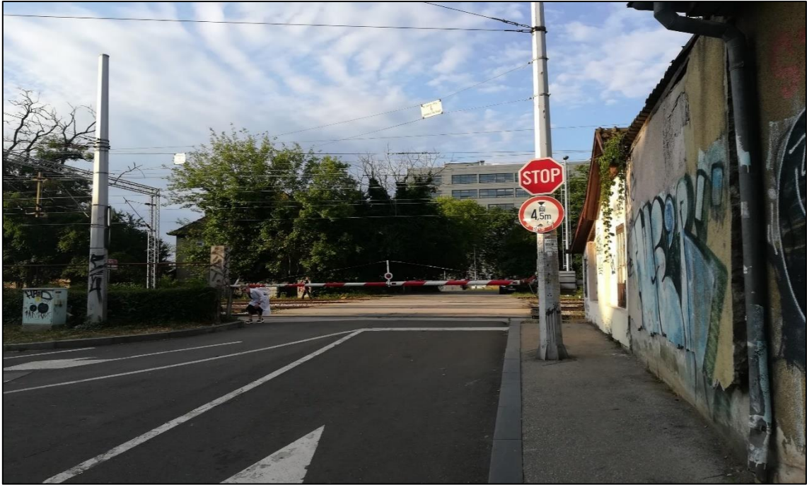
Slika 16. Željezničko-cestovni prijelaz „R. Austrije“ iz smjera sjevera
