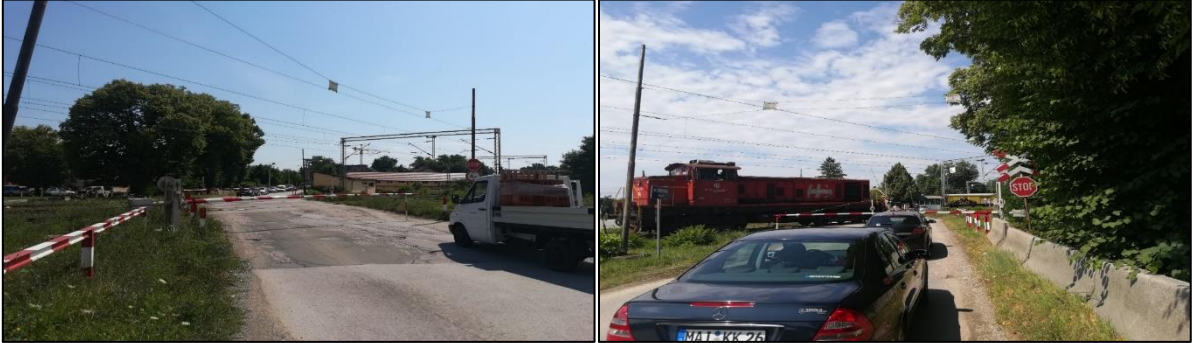
Slika 109. Željezničko-cestovni prijelaz „Horvatova“ iz smjera zapada Slika 110. Željezničko-cestovni prijelaz „Horvatova“ iz smjera istoka
