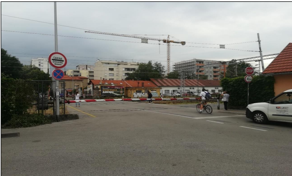
Slika 22. Željezničko-cestovni prijelaz „Vodovodna“ iz smjera juga
