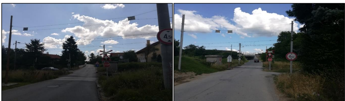
Slika 81. Željezničko-cestovni prijelaz „Demerje“ iz smjera sjevera Slika 82. Željezničko-cestovni prijelaz „Demerje“ iz smjera juga
