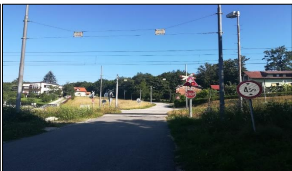
Slika 66. Željezničko-cestovni prijelaz „Horvati“ iz smjera juga
