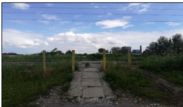
Slika 139. Željezničko-cestovni prijelaz „Resnik“ iz smjera zapada
