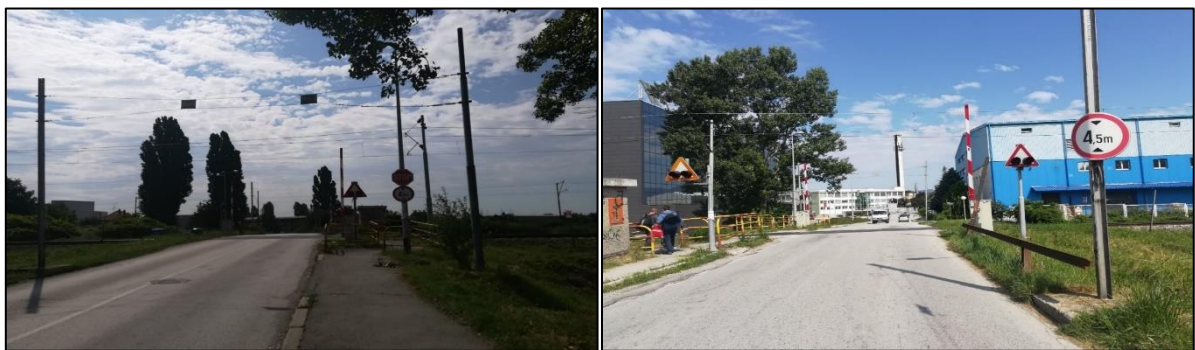
Slika 97. Željezničko-cestovni prijelaz „Savski Gaj“ iz smjera sjevera Slika 98. Željezničko-cestovni prijelaz „Savski Gaj“ iz smjera juga
