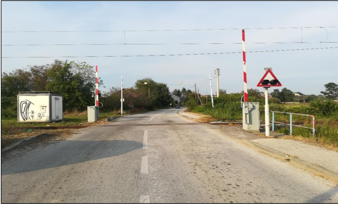
Slika 4. Željezničko-cestovni prijelaz osiguran sa svjetlosno-zvučnom signalizacijom i polubranicima , Križ
