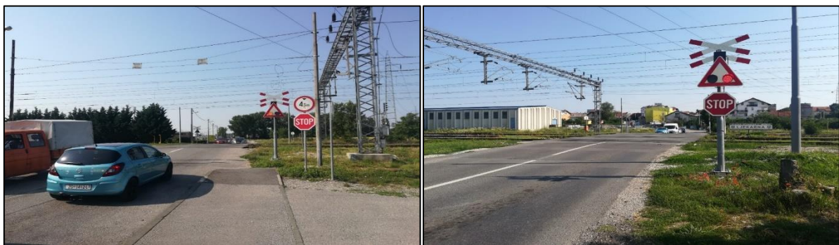
Slika 41. Željezničko-cestovni prijelaz „Jelkovečka“ iz smjera sjevera Slika 42. Željezničko-cestovni prijelaz „Jelkovečka“ iz smjera juga
