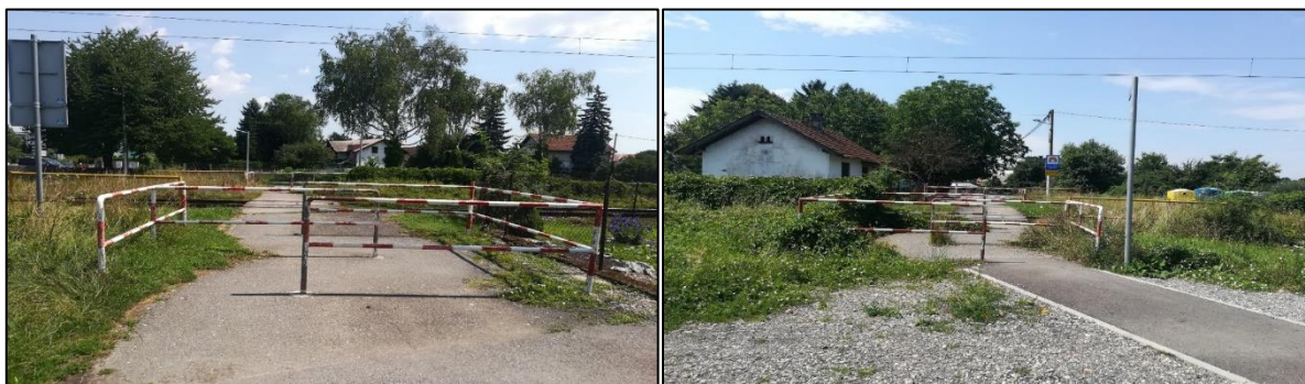
Slika 121. Željezničko-cestovni prijelaz „Ul. Mlad.“ iz smjera zapada Slika 122. Željezničko-cestovni prijelaz „Ul. Mlad.“ iz smjera istoka
