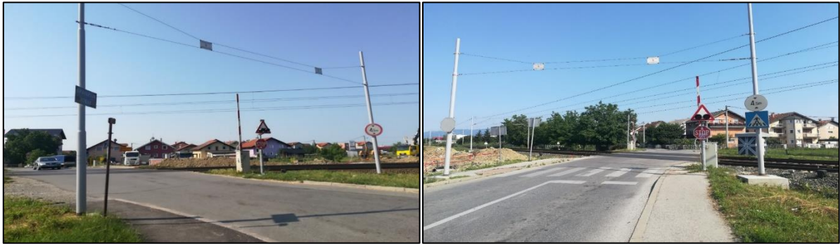
Slika 45. Željezničko-cestovni prijelaz „Selnica“ iz smjera sjevera Slika 46. Željezničko-cestovni prijelaz „Selnica“ iz smjera juga
