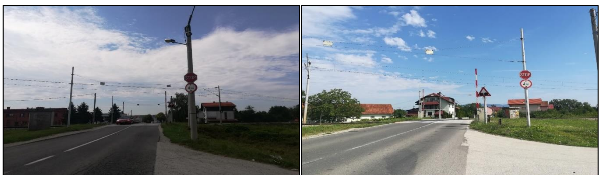
Slika 89. Željezničko-cestovni prijelaz „Brezovečka“ iz smjera sjevera Slika 90. Željezničko-cestovni prijelaz „Brezovečka“ iz smjera juga
