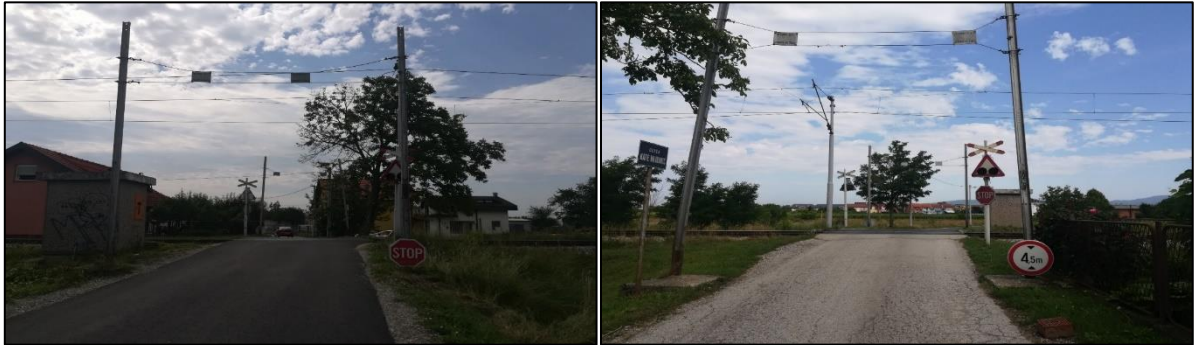
Slika 93. Željezničko-cestovni prijelaz „K. Mlinarić“ iz smjera sjevera Slika 94. Željezničko-cestovni prijelaz „K. Mlinarić“ iz smjera juga
