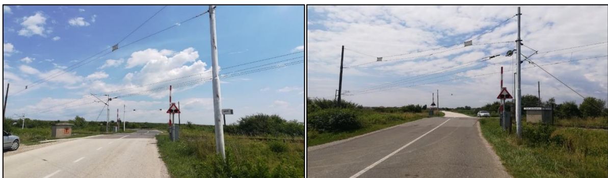
Slika 129. Željezničko-cestovni prijelaz „Mićevac“ iz smjera zapada Slika 130. Željezničko-cestovni prijelaz „Mićevac“ iz smjera istoka
