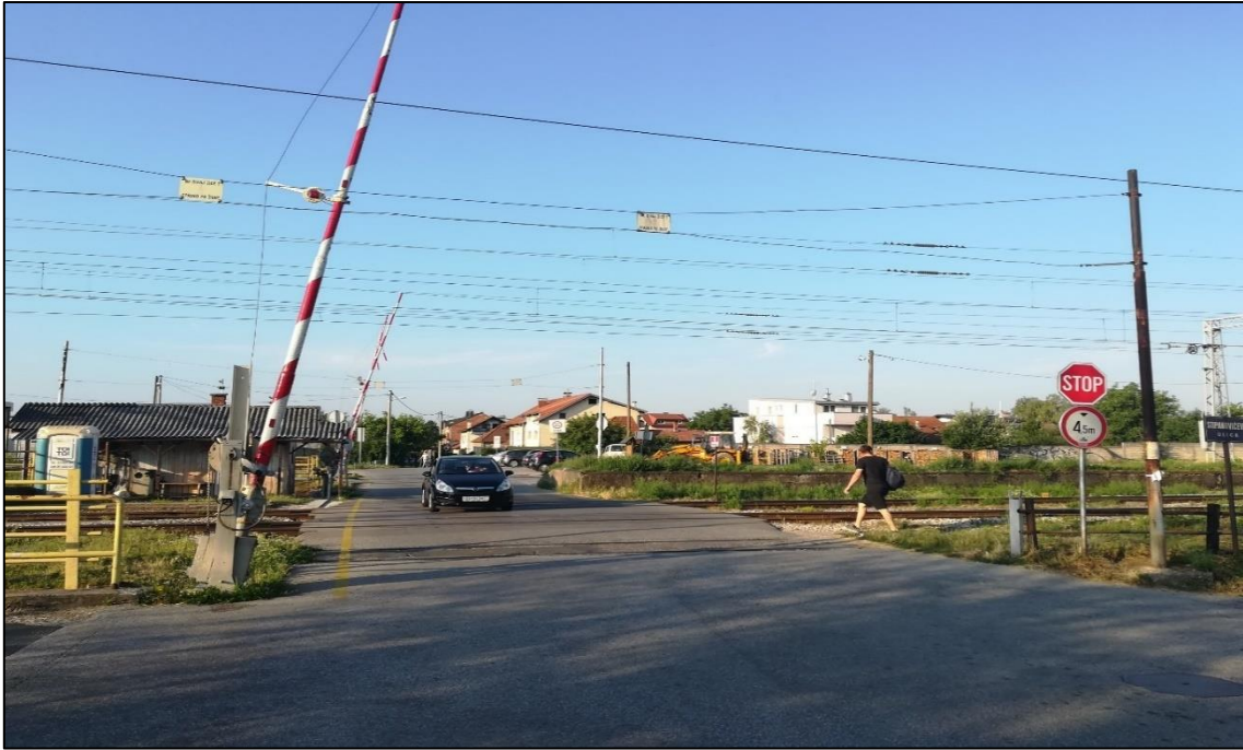
Slika 25. Željezničko-cestovni prijelaz „Sokolska“ iz smjera sjevera
