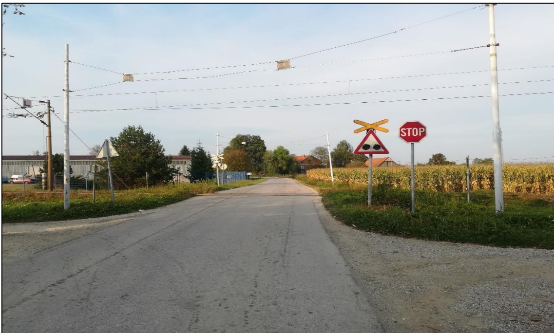
Slika 3. Željezničko-cestovni prijelaz osiguran sa svjetlosno-zvučnom signalizacijom i "Andrijinim križem", Okešinac
