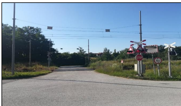
Slika 65. Željezničko-cestovni prijelaz „Horvati“ iz smjera sjevera
