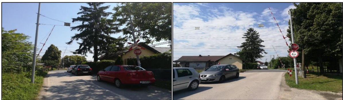
Slika 105. Željezničko-cestovni prijelaz „Mrkšina“ iz smjera zapada Slika 106. Željezničko-cestovni prijelaz „Mrkšina“ iz smjera istoka
