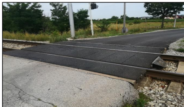
Slika 95. Prikaz stanja gumirane podloge na željezničko-cestovnom prijelazu „K. Mlinarić“
