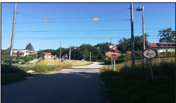
Slika 66. Željezničko-cestovni prijelaz „Horvati“ iz smjera juga
