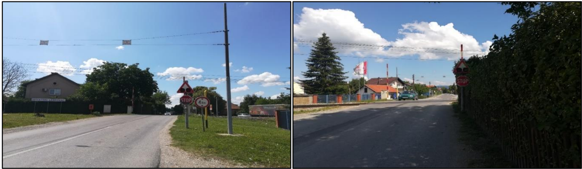
Slika 77. Željezničko-cestovni prijelaz „Bedekova“ iz smjera sjevera Slika 78. Željezničko-cestovni prijelaz „Bedekova“ iz smjera juga
