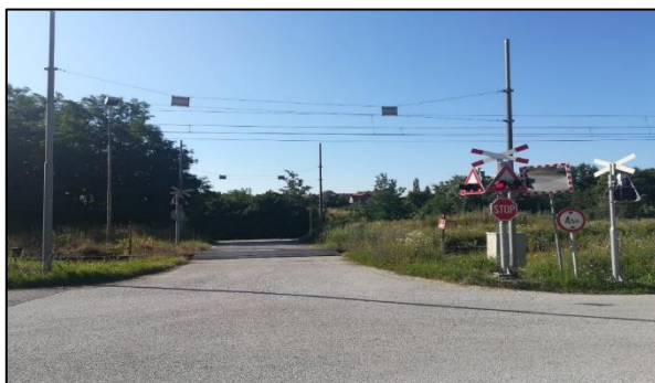
Slika 65. Željezničko-cestovni prijelaz „Horvati“ iz smjera sjevera
