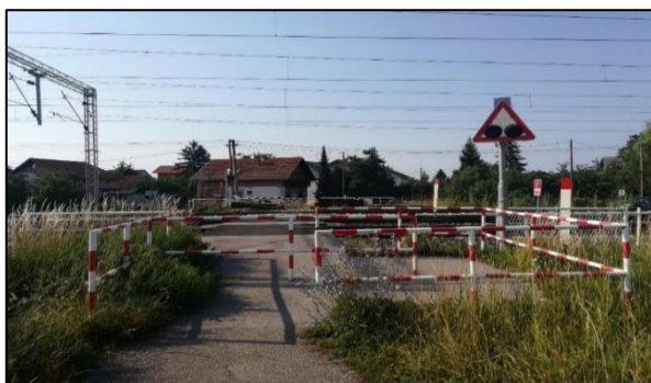
Slika 33. Željezničko-cestovni prijelaz „Treska“ iz smjera sjevera
