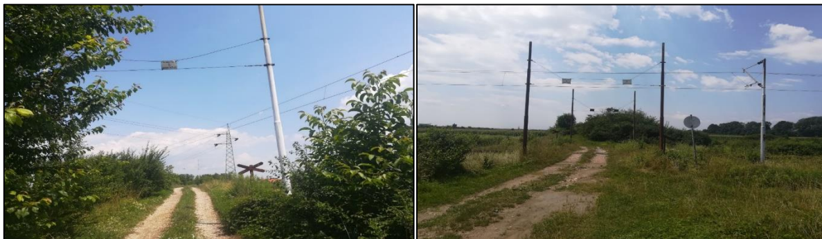
Slika 133. Željezničko-cestovni prijelaz „Polj. put“ iz smjera zapada Slika 134. Željezničko-cestovni prijelaz „Polj. put“ iz smjera istoka
