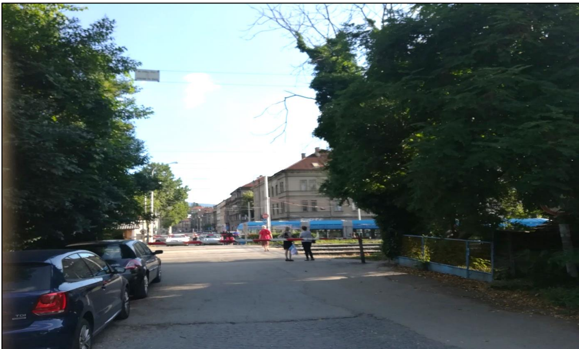
Slika 17. Željezničko-cestovni prijelaz „R. Austrije“ iz smjera juga
