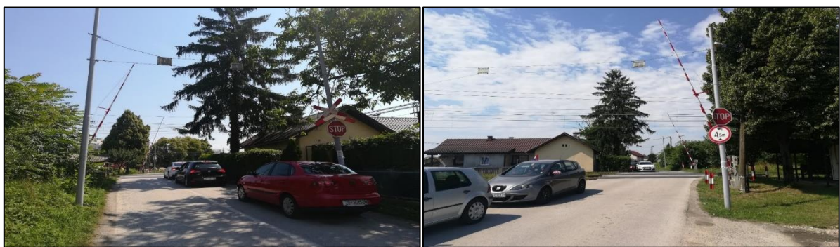
Slika 105. Željezničko-cestovni prijelaz „Mrkšina“ iz smjera zapada Slika 106. Željezničko-cestovni prijelaz „Mrkšina“ iz smjera istoka
