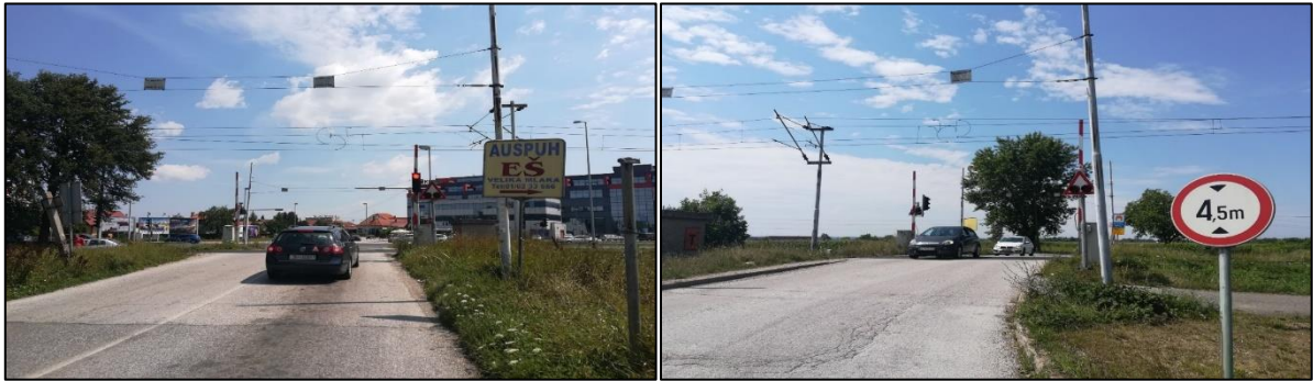
Slika 117. Željezničko-cestovni prijelaz „Buzin“ iz smjera zapada Slika 118. Željezničko-cestovni prijelaz „Buzin“ iz smjera istoka
