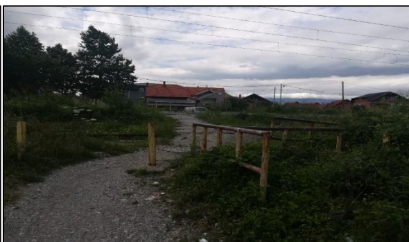
Slika 140. Željezničko-cestovni prijelaz „Resnik“ iz smjera istoka
