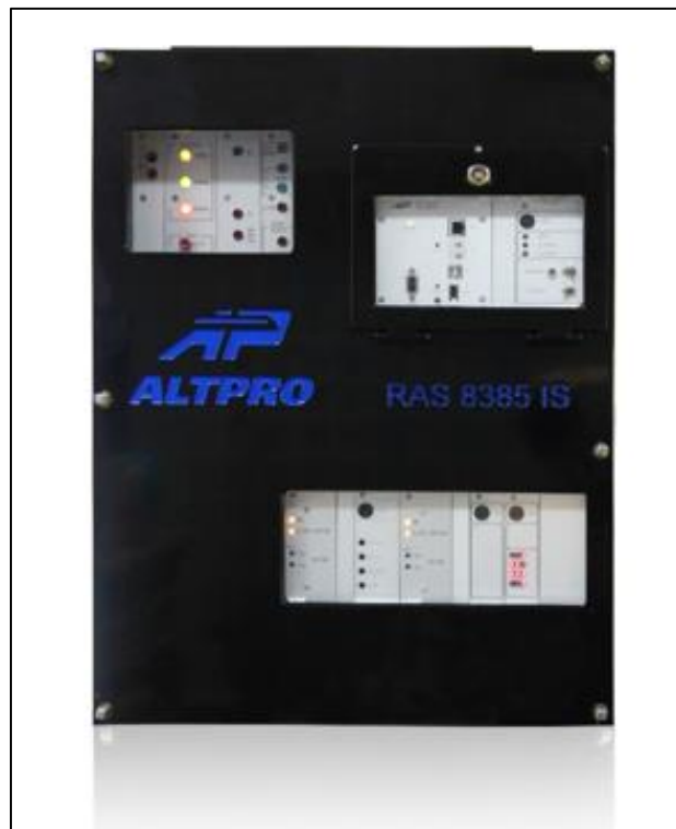
Slika 8. Centralna jedinica ATP sustava RAS8385IS [autor]
