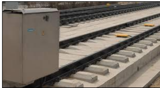
Slika 25. LEU - Lineside Electronic Unit s fiksnom i promjenjivom balizom [24]
