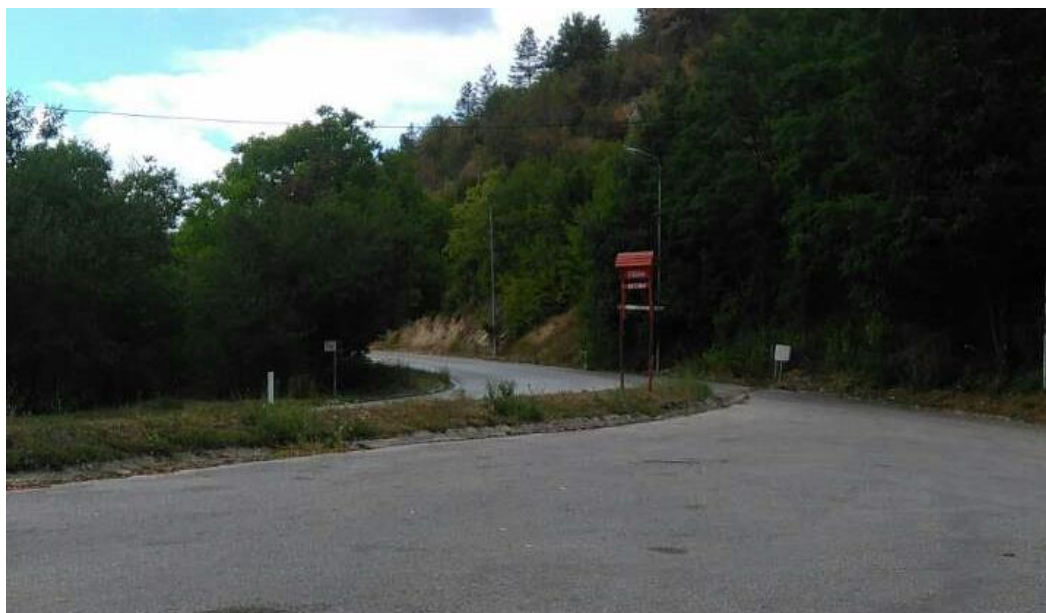
Slika 6.12 Opasno mjesto Ul. Bihački put priključak lokalne ceste
