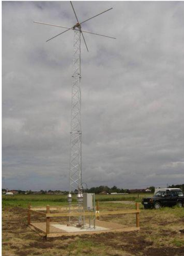
Slika 9. Antena NDB-a
