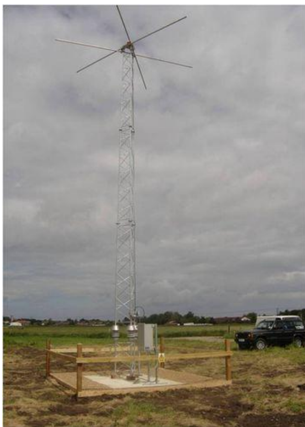
Slika 9. Antena NDB-a
