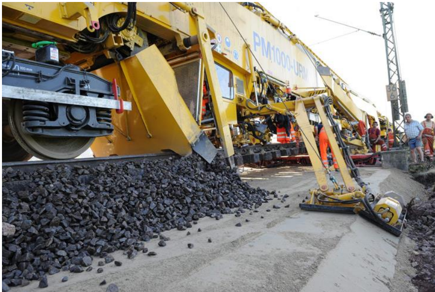
Slika 22. Poravnavanje tamponskoj sloja i istovaranje kamena tučenca [6]
