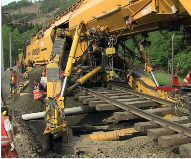
Slika 20. Stroj za izgradnju donjeg ustroja pruge [6]
