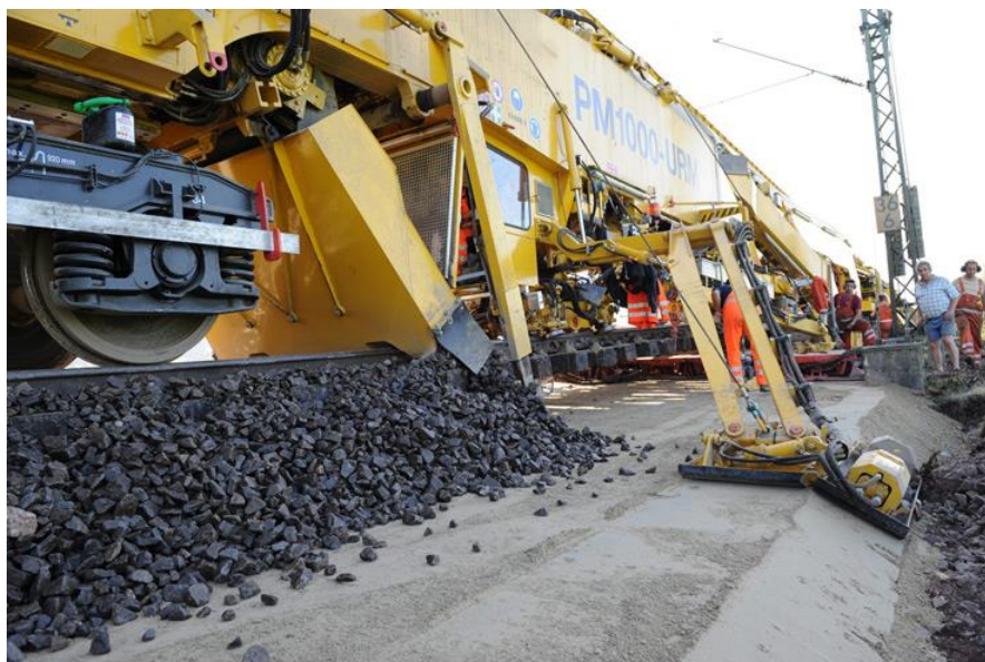
Slika 22. Poravnavanje tamponskoj sloja i istovaranje kamena tučenca [6]
