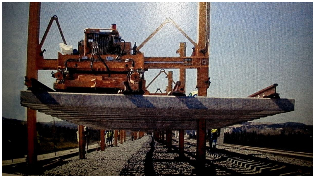
Slika 19. Višedijelni stroj za izmjenu skretnica [4]
