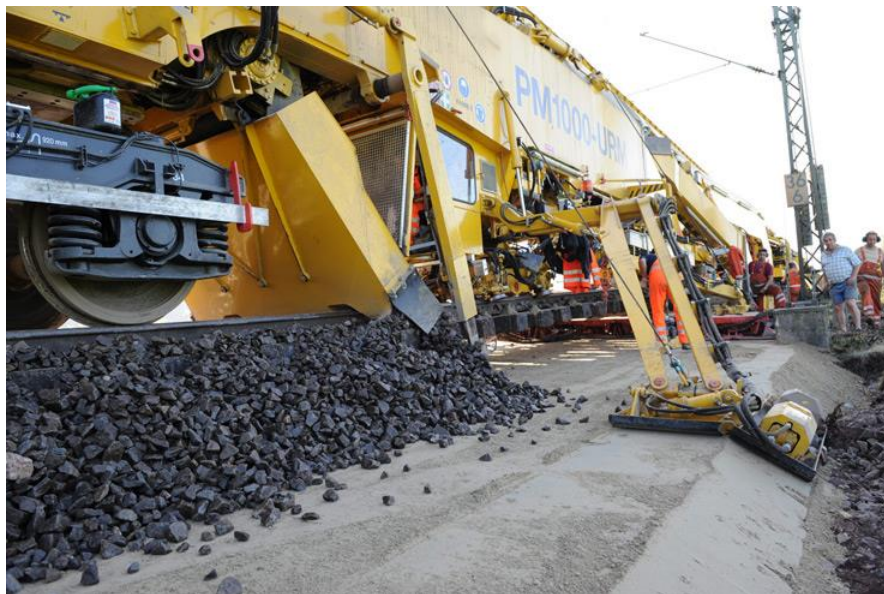
Slika 22. Poravnavanje tamponskoj sloja i istovaranje kamena tučenca [6]
