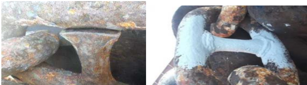
Slika 25. Prikaz nepravilnog zavarivanja
