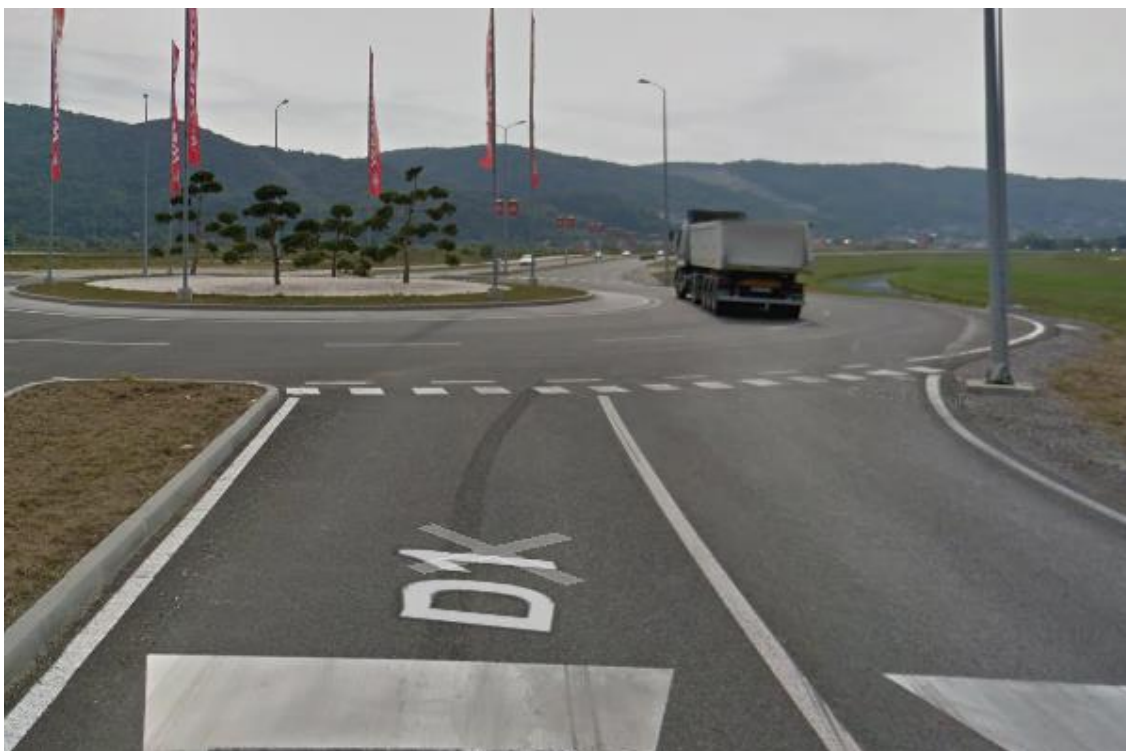
Slika 23. Pogled na „Raskrižje broj 3“ sa sjevernog privoza [7]
