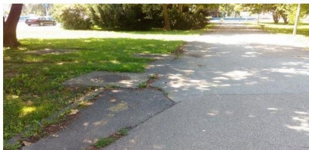
Slika 19. Prikaz loše uočljive horizontalne signalizacije
