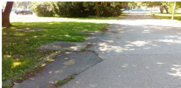
Slika 19. Prikaz loše uočljive horizontalne signalizacije
