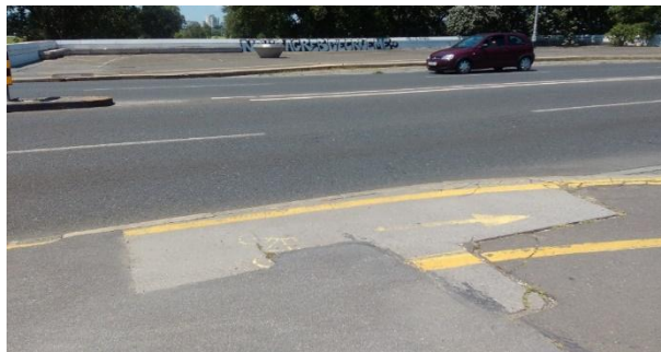
Slika 11. Prikaz oštećene i nepravilno odvojene biciklističke staze od ruba kolnika na Mostu Slobode
