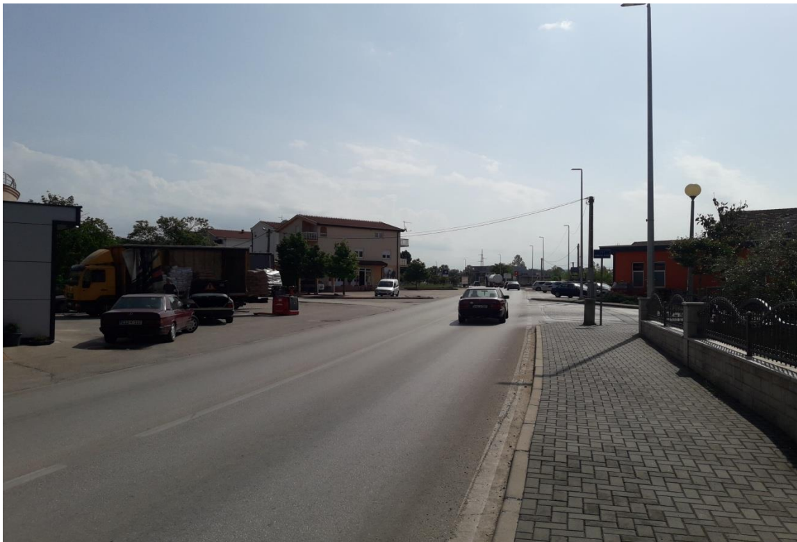
Slika 17. Pogled sa zapadnog privoza na raskrižju 3
