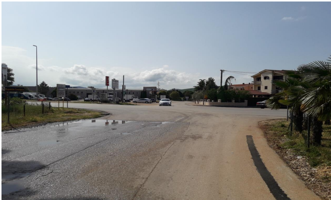
Slika 13. Pogled sa zapadnog privoza na raskrižju 2
