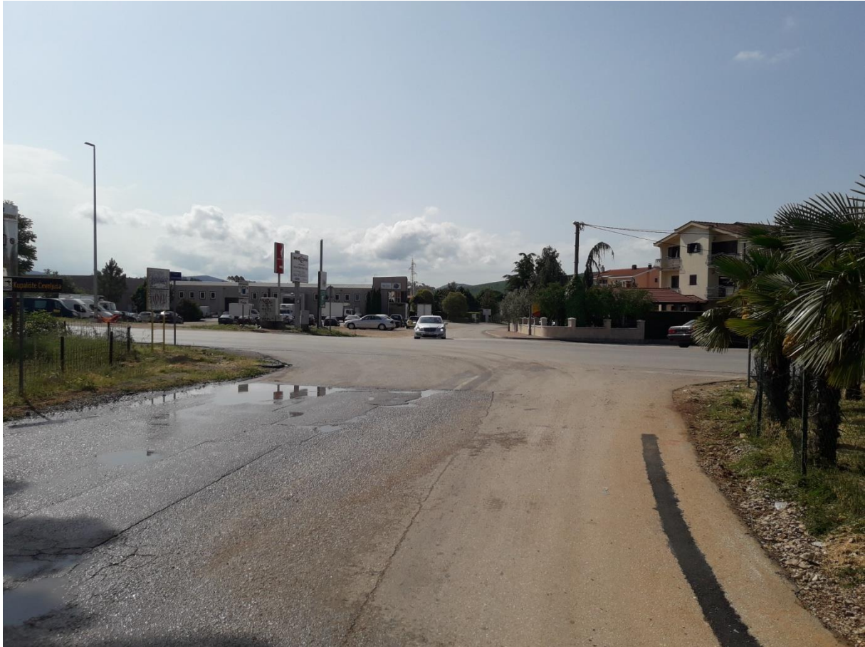
Slika 22. Nedovoljna preglednost sa zapadnog privoza na raskrižju 2
