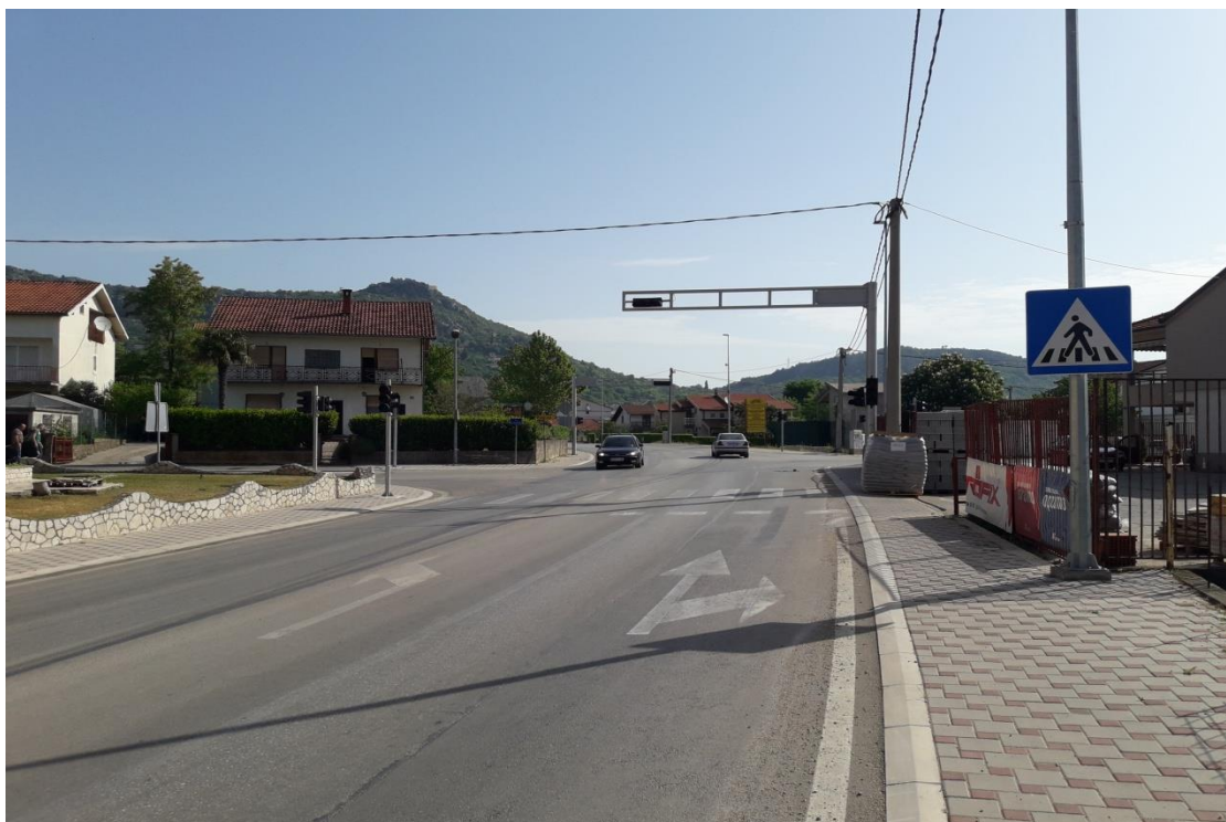
Slika 8. Pogled sa južnog privoza na raskrižju 1
