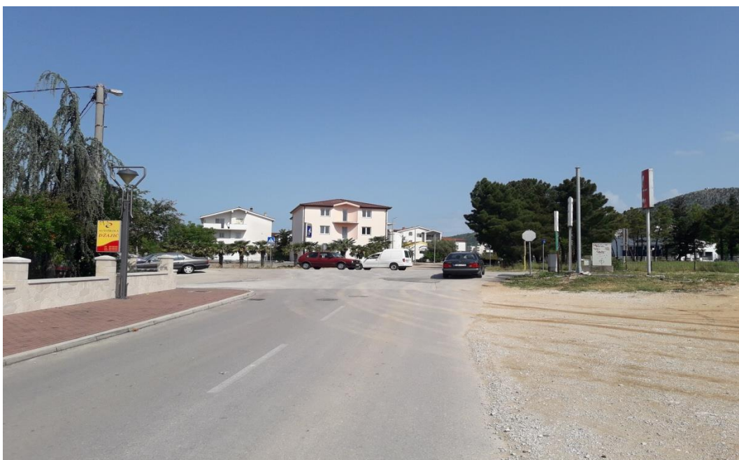
Slika 11. Pogled sa istočnog privoza na raskrižju 2
