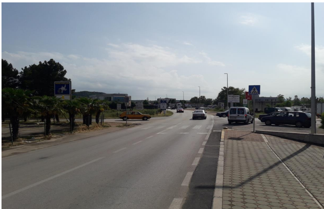
Slika 12. Pogled sa južnog privoza na raskrižju 2
