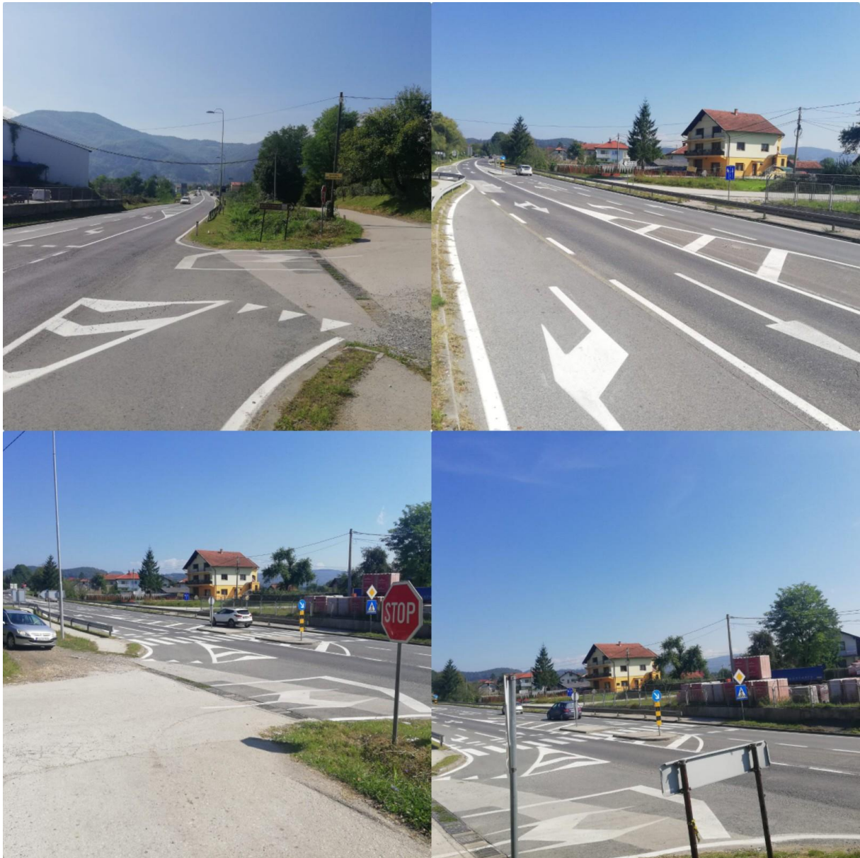
Slika 17. Postojeće stanje raskrižja u razini
