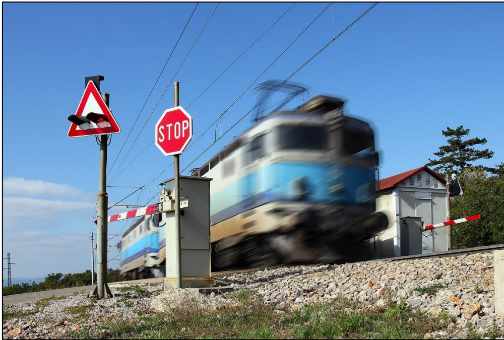
Slika 37. Željezničko-cestovni prijelaz „Tuhobić“ [29]
