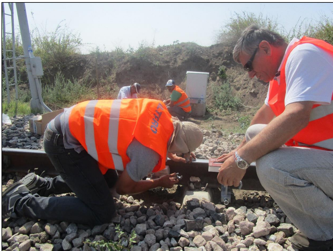
Slika 35. Ugradnja senzora ZK24-2 na željezničko-cestovnom prijelazu u Turskoj [29]
