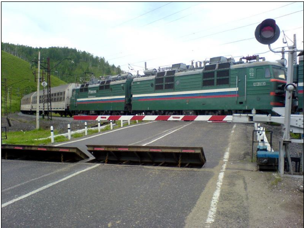
Slika 15. Željezničko-cestovni prijelaz u Rusiji osiguran izlazećim rampama [22]
