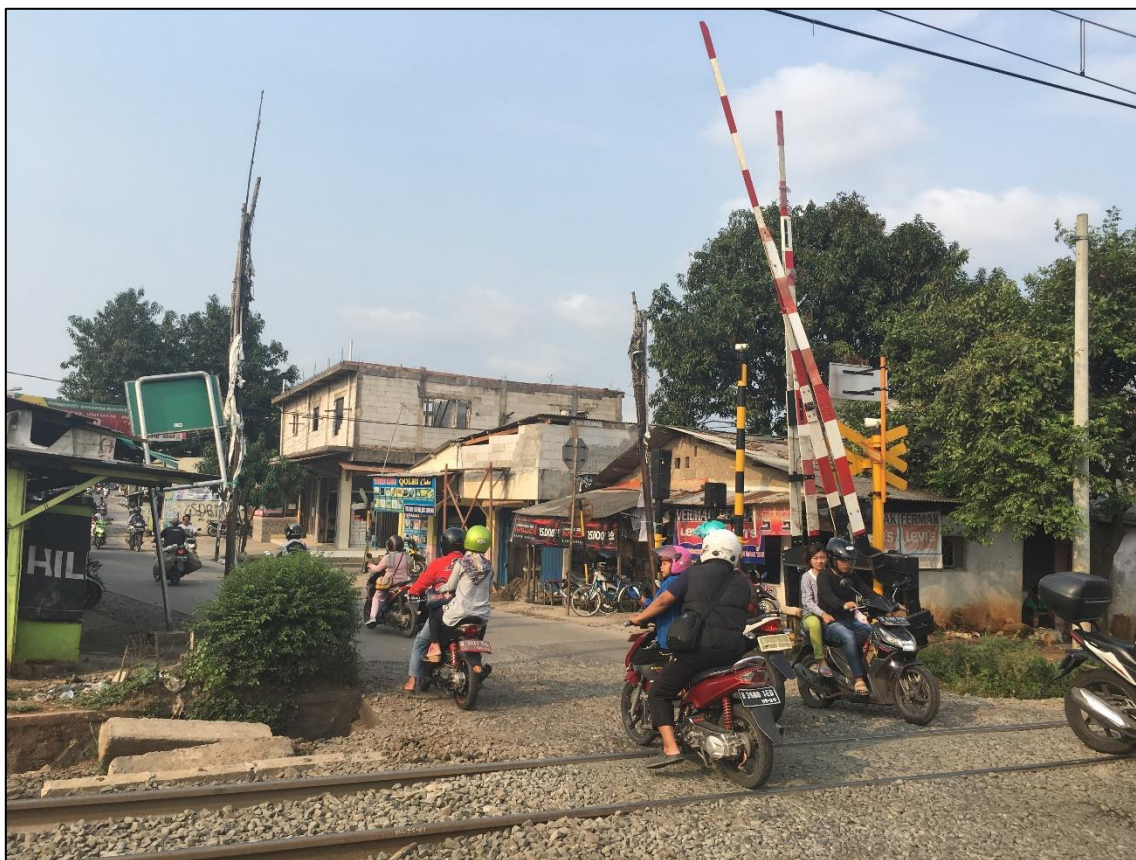
Slika 39. Željezničko-cestovni prijelaz u Indoneziji [29]
