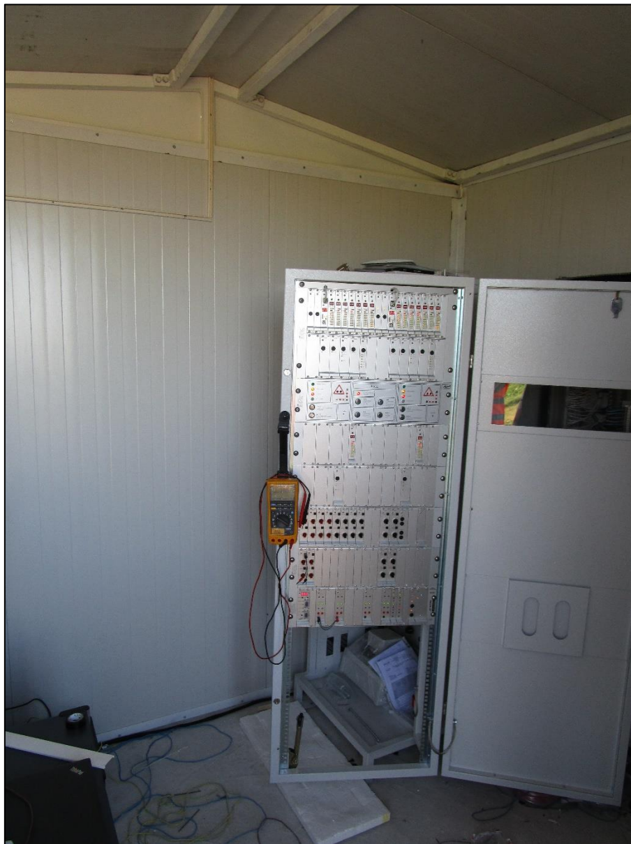
Slika 34. Proces ugradnje upravljačkog ormara uređaja RLC23 u Turskoj [29]
