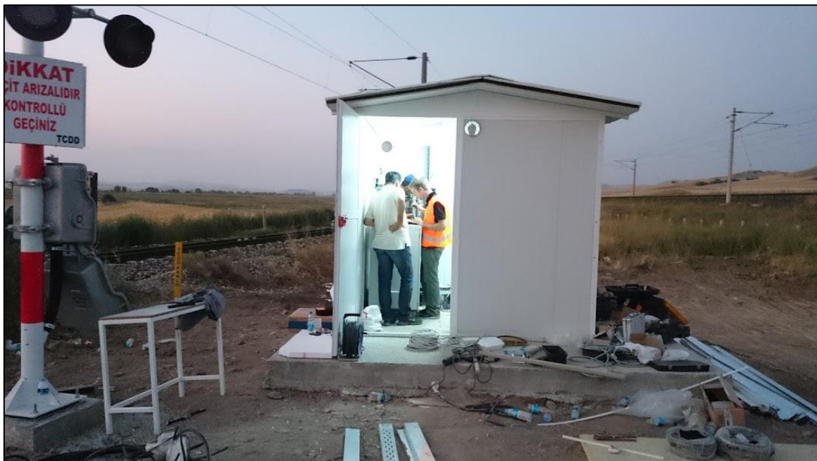
Slika 33. Ugradnja upravljačkog ormara uređaja RLC23 u Turskoj [29]
