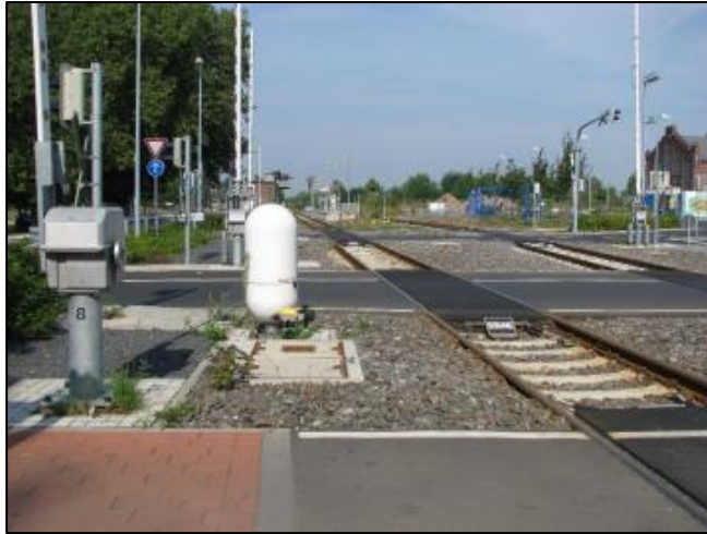
Slika 18. Radarska tehnologija na željezničko-cestovnom prijelazu u Njemačkoj [24]
