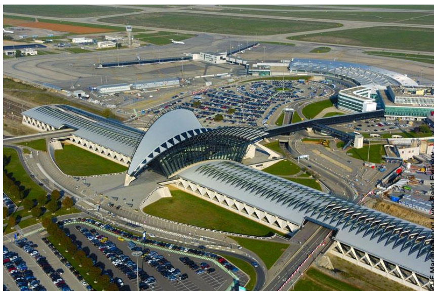
Slika 5.10. TGV stanica Lyon Saint- Exupery [40]
