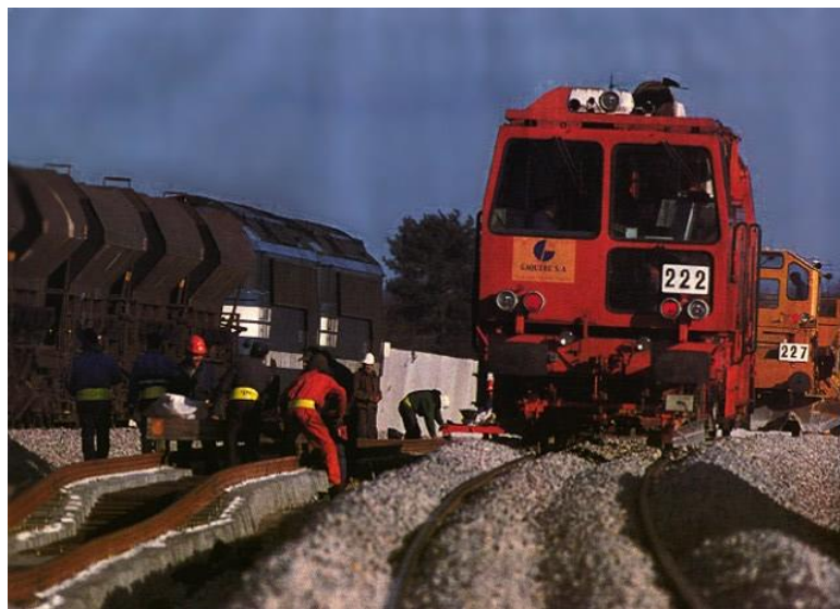
Slika 5.5. Izgradnja drugog kolosijeka [31]
