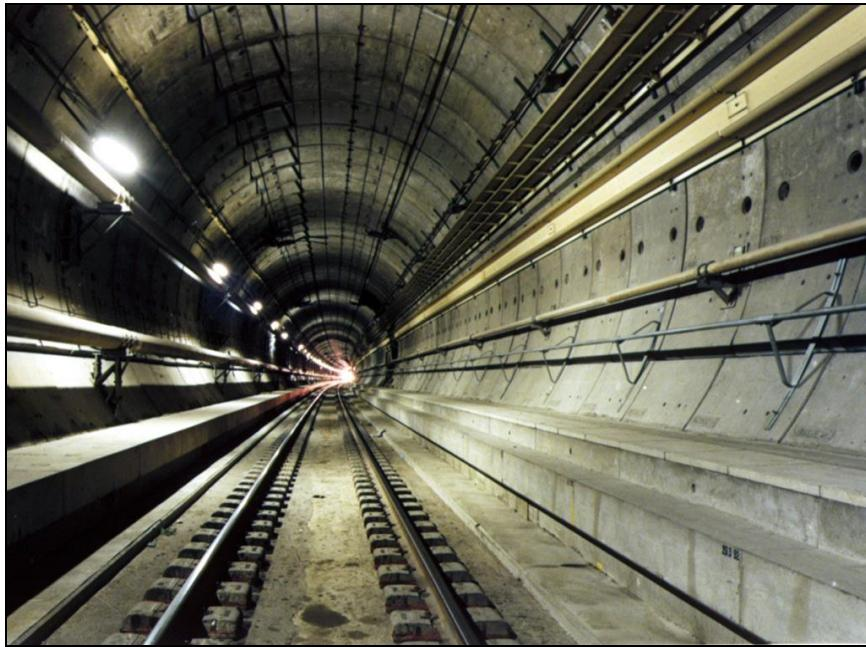
Slika 4.2. Kolosijek za vlakove velikih brzina u tunelu [19]
