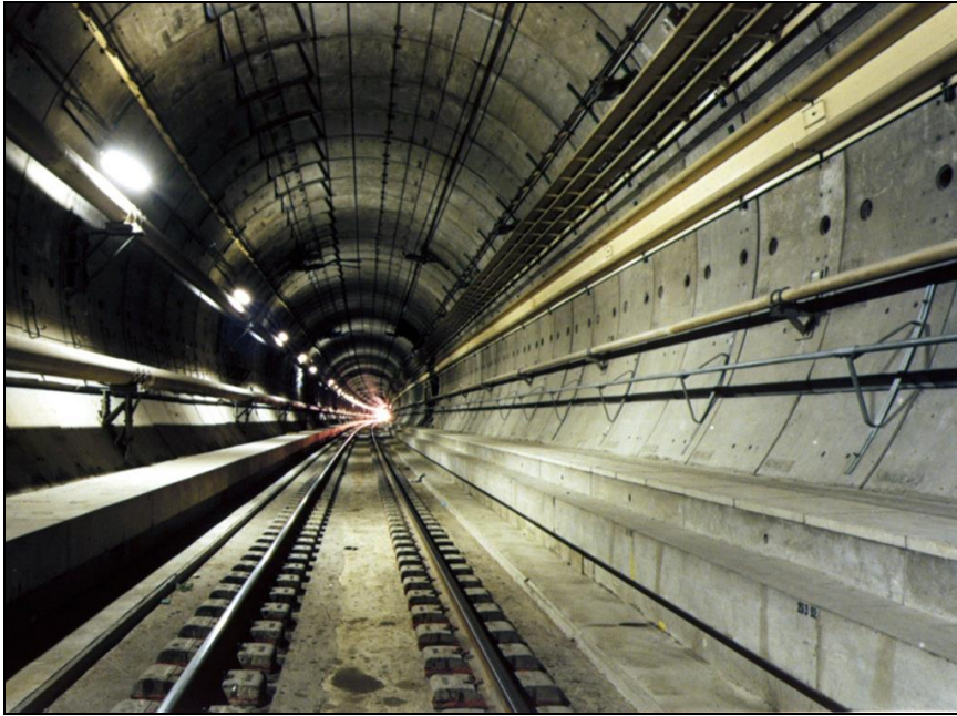
Slika 4.2. Kolosijek za vlakove velikih brzina u tunelu [19]
