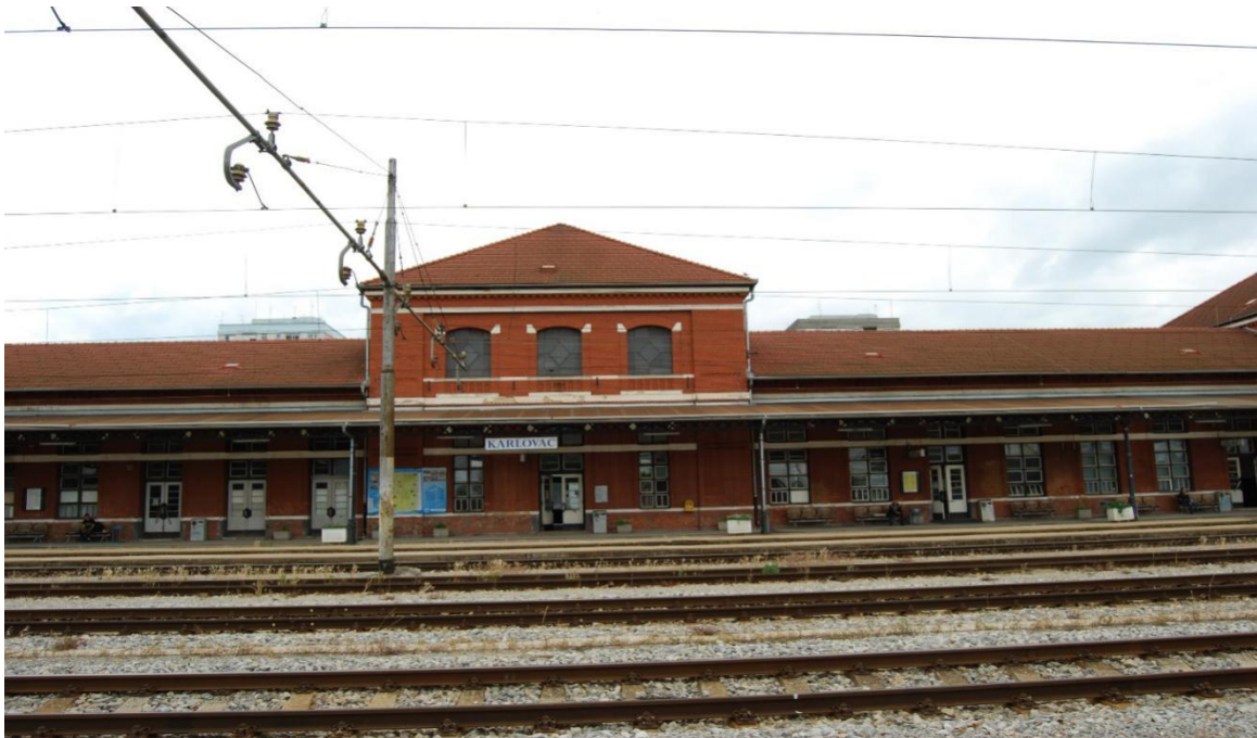
Slika 1. Kolodvorska zgrada u kolodvoru Karlovac
