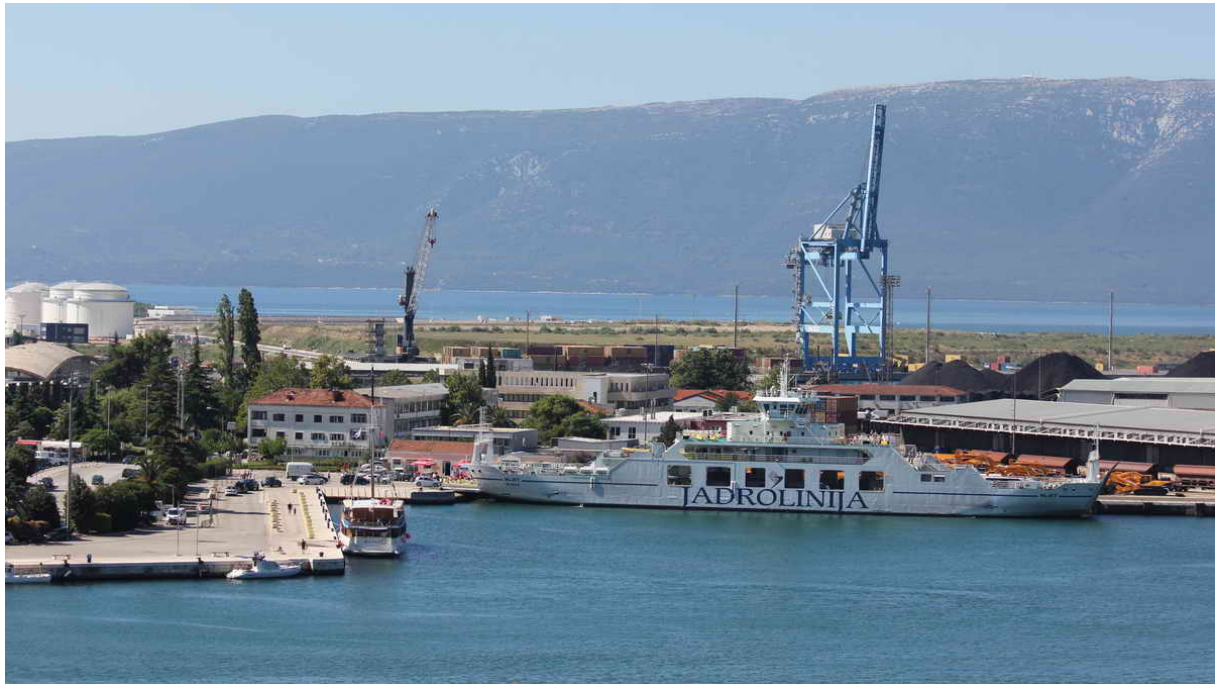
Slika 7. Putnički terminal luke Ploče
