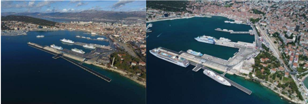
Slika 17. Novi vezovi za brodove na kružnim putovanjima u Gradskoj luci u Splitu
