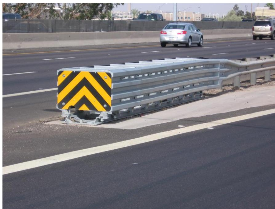
**Slika 4.** Prikaz primjera adekvatnog završnog elementa zaštitne odbojne ograde [9]
