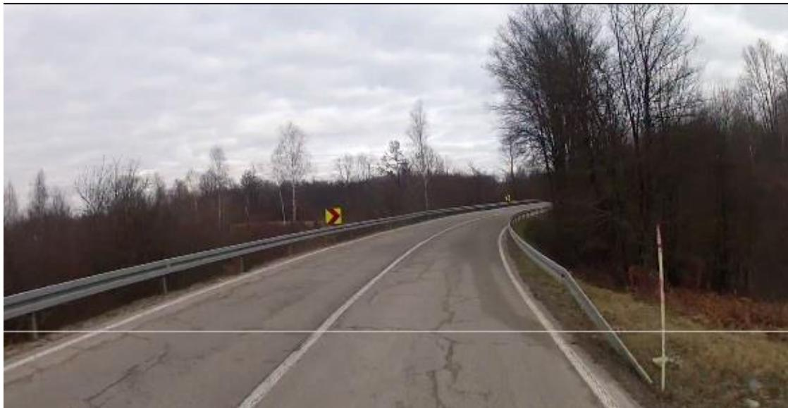
**Slika 3.** Prikaz neadekvatnog završnog elementa zaštitne odbojne ograde na cesti D3 [2]
