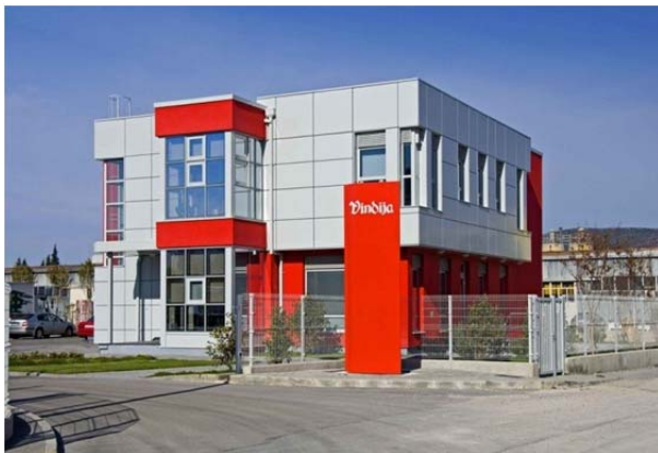
Slika 9 Upravna zgrada DC-a Metković, Vindija d.d [16]
