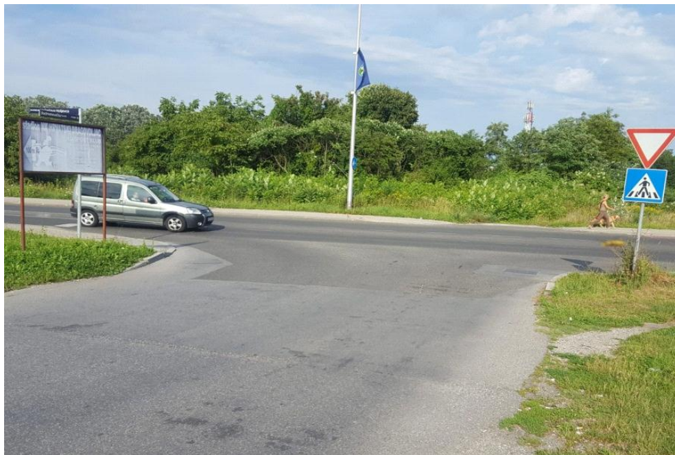
Slika 17. Primjer nepostojanja nogostupa niti pješačkog prijelaza
