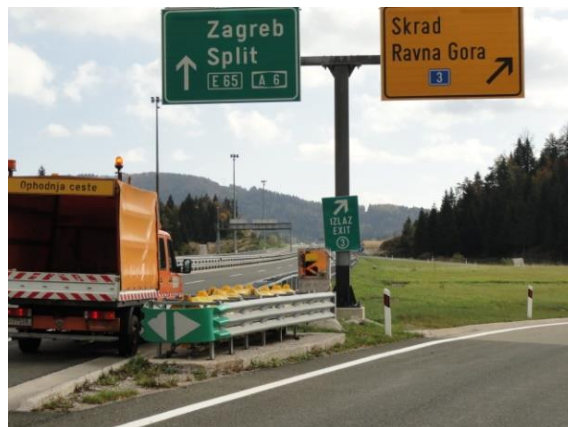
Slika 55.: Ublaživač udara – raskrižje izvan razine Ravna Gora [19]
