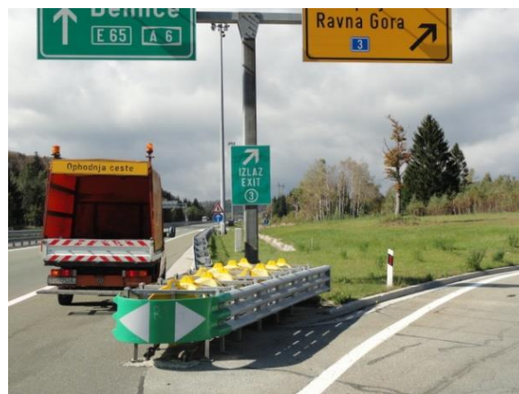
Slika 57.: Ublaživač udara - raskrižje izvan razine Ravna Gora [19]
