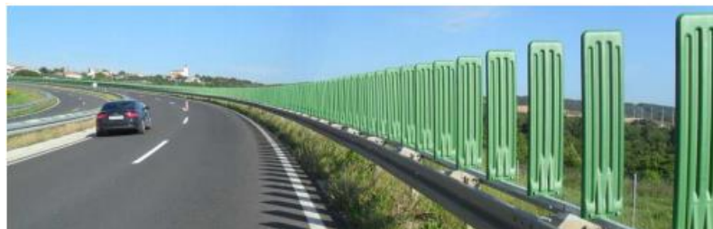
Slika 38.: Ograda protiv zasljepljivanja [9]
