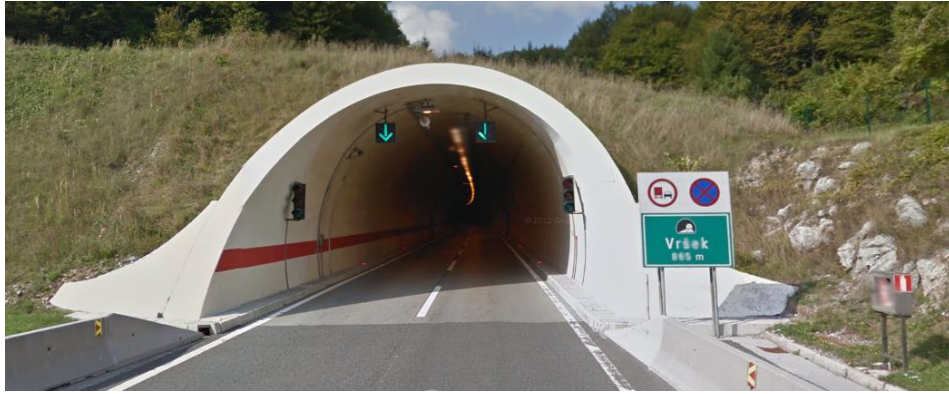
Slika 45.: Ulaz tunela Vršek [10]
