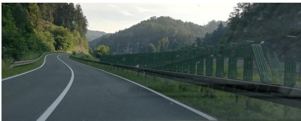
Slika 49. Ograda protiv zasljepljivanja u blizini autoceste A2 u naselju Donji Macelj
