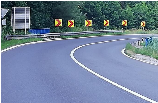
a) zaštitna ograda na objektu
