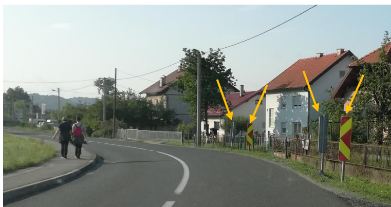
Slika 47. Neispravno označen zavoj u naselju Švaljkovec
