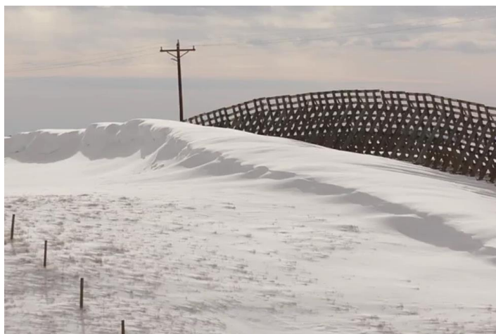
Slika 22. Privremeni drveni snjegobran
