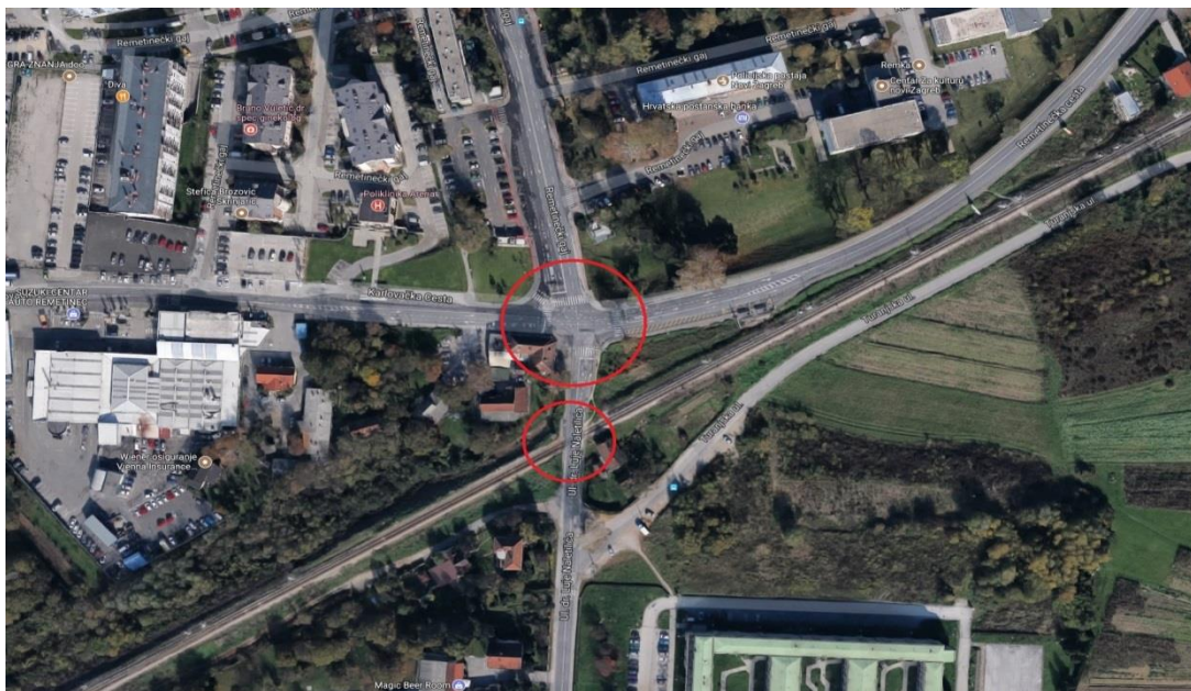
Slika 4. Raskrižje Karlovačke ulice i Ulice dr. Luje Naletilića te željezničke pruge [13]
