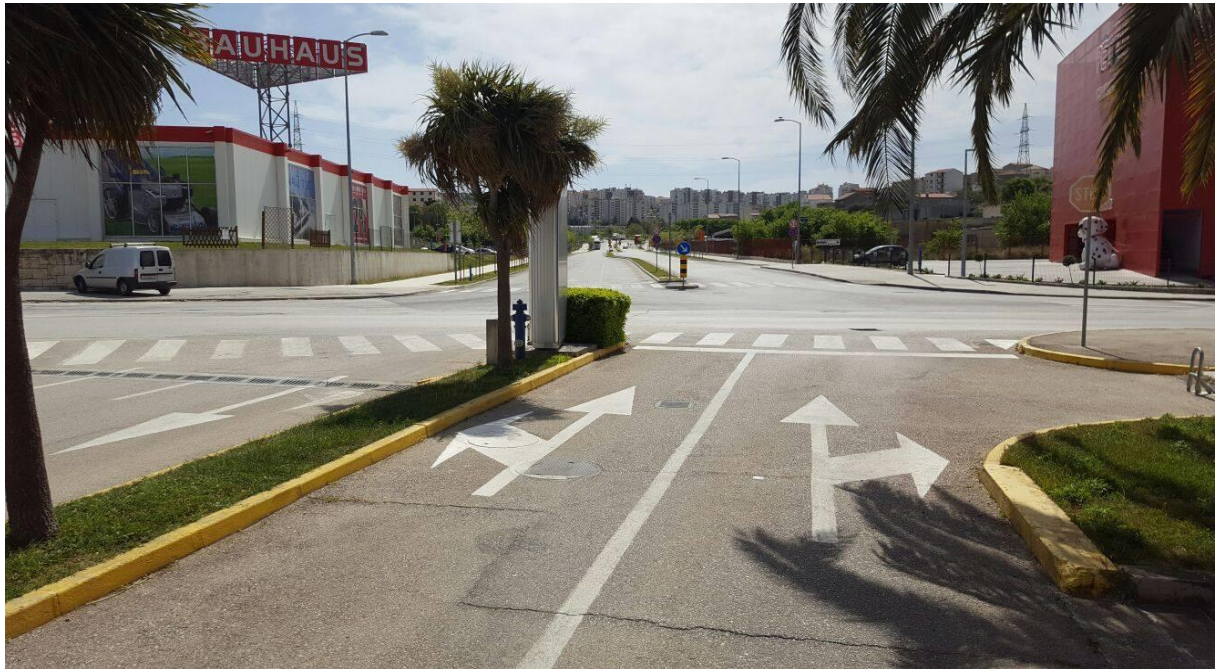
Slika 3. Sjeverni privoz raskrižju
