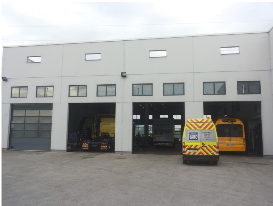
Slika 12 Ulaz u radionicu
