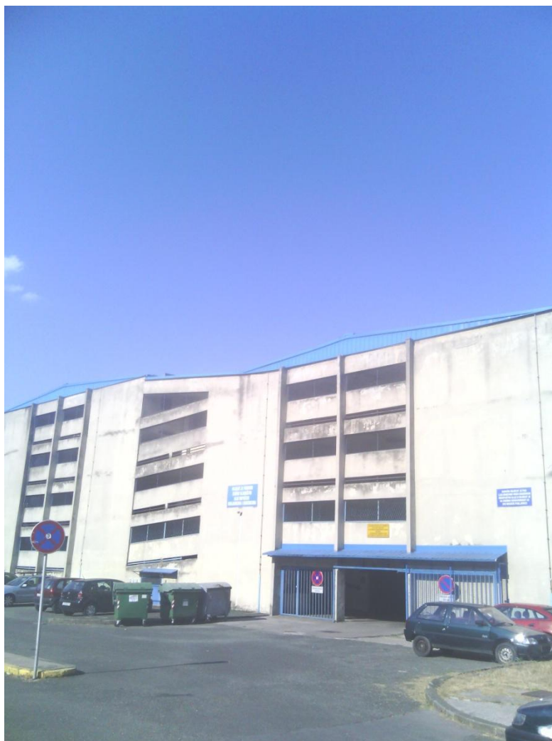
Slika 17. Garažni objekt izgrađen u analiziranoj gradskoj četvrti Utrina, Novi Zagreb
