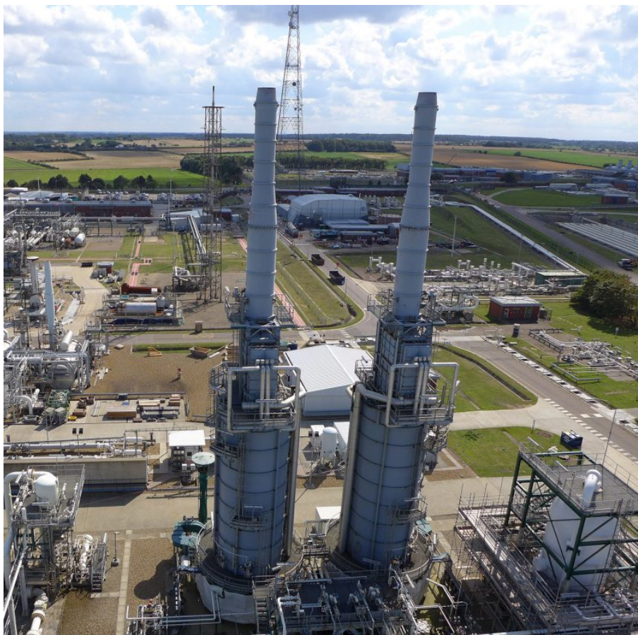
Slika 32. Inspekcija dvaju tornjeva u postrojenju Bacton
