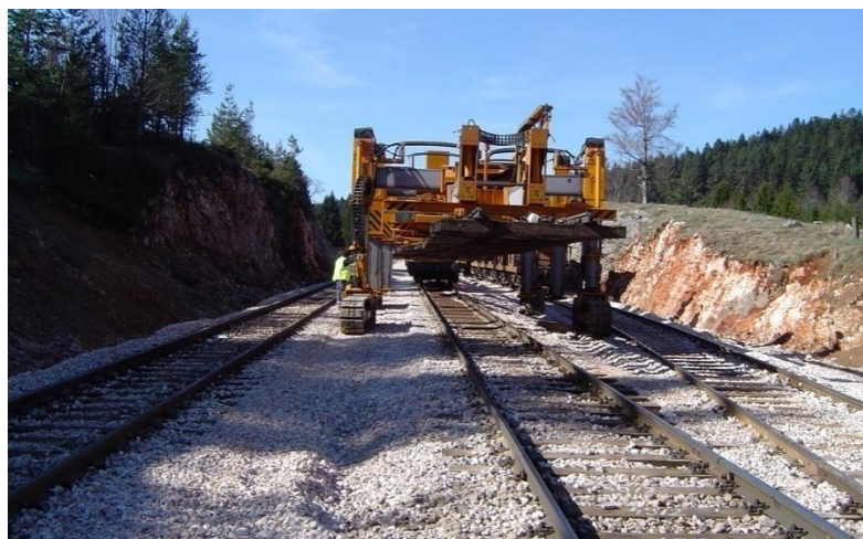
Slika 8. Višedijelni stroj za izmjenu skretnica, [8]
