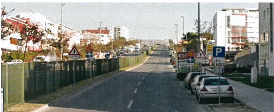
Slika 11. Prikaz preglednosti na dijelu predmetne dionice
