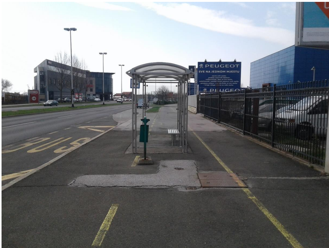
Slika 11. Prikaz nepropisne signalizacije na dvosmjernoj biciklističkoj stazi uz Branimirovu cestu
