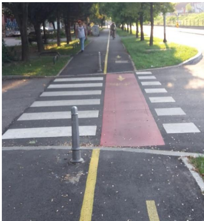
Slika 13. Biciklistička staza u Koturaškoj ulici u Zagrebu
