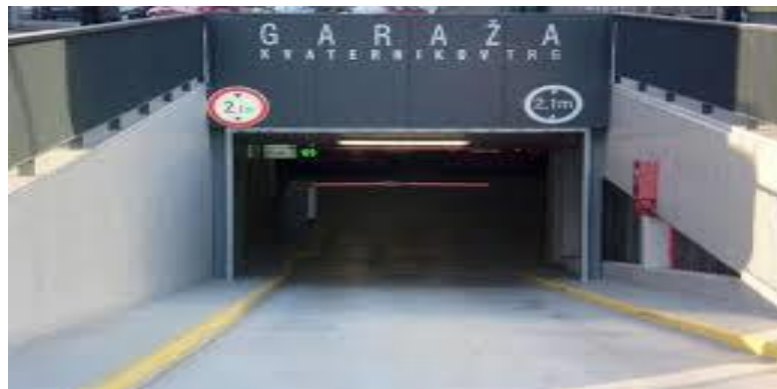
Slika 18. Ulaz u podzemnu garažu Kvaternikov trg [8]
