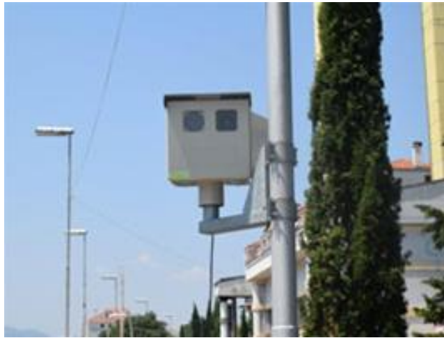
Slika 19: Uređaj za automatsku kontrolu brzine kretanja vozila i automatsko očitavanje registarskih oznaka [38]
