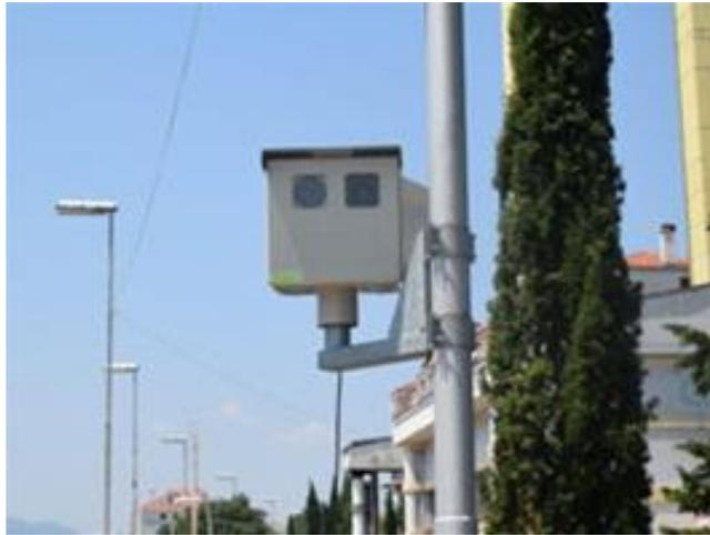
Slika 19: Uređaj za automatsku kontrolu brzine kretanja vozila i automatsko očitavanje registarskih oznaka [38]
