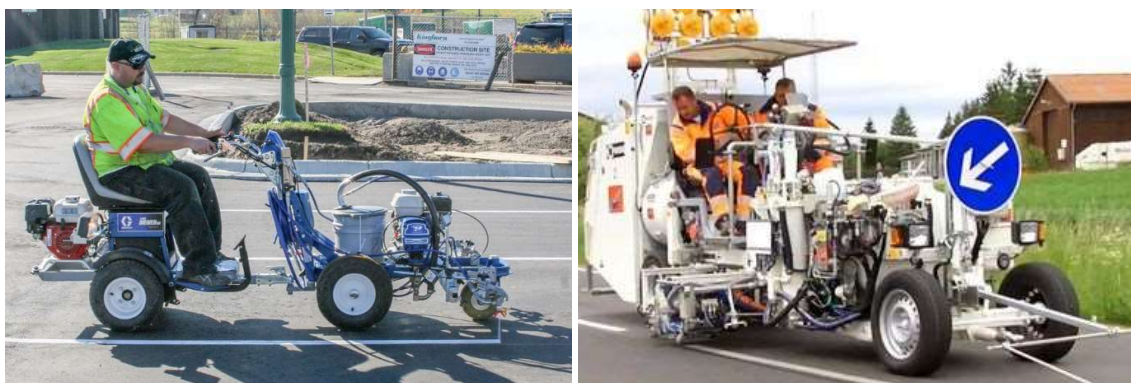
Slika 23. Izvođenje bojanih oznaka strojem maloga (lijevo) i većega (desno) kapaciteta
