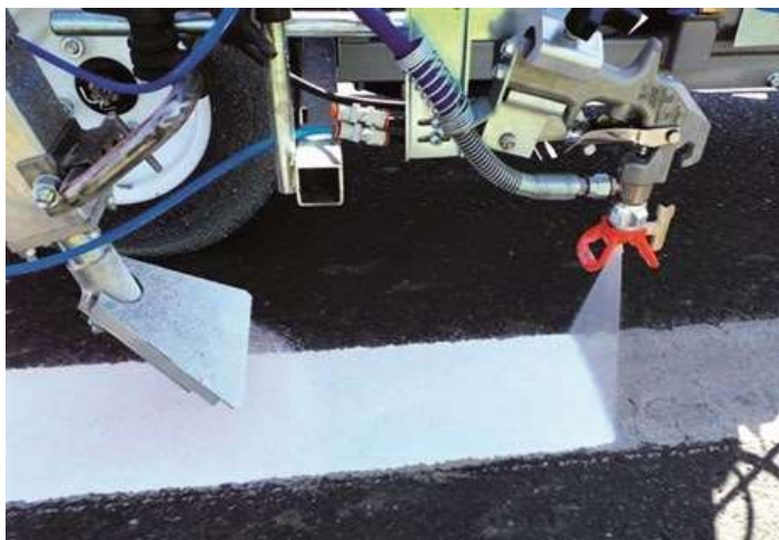
Slika 24. Prikaz nanošenja boje i staklenih perla na kolnik
