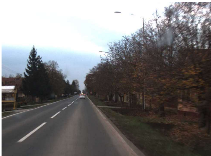
Slika 12. Razlika u dnevnoj vidljivosti prljave rubne i čiste središnje linije
