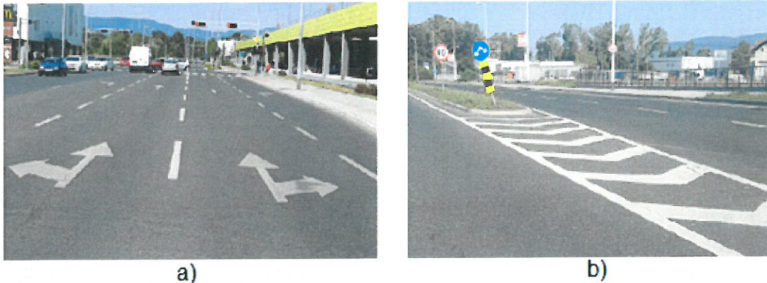
Slika 50. Primjer izvedbe oznaka na kolniku: a) oznaka H21 u Ulici Siniše Glavaševića, b) oznaka H32 na Slavonskoj aveniji
