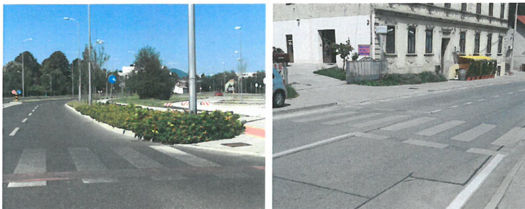
Slika 56. Primjer istrošenih oznaka na kolniku
