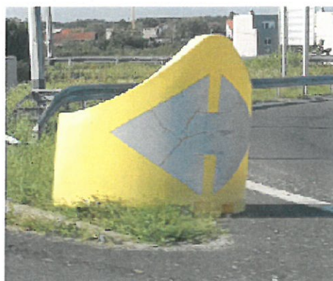
Slika 36. Primjer postavljanja ploča za označivanje prometnog otoka K07 na izlazu Zagreb istok i Kraljevečki Novaki
