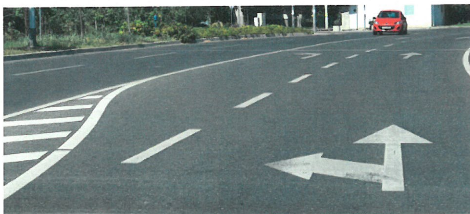
Slika 48. Primjer izvedbe uzdužne oznake na kolniku tip H02 u Ulici Siniše Glavaševića
