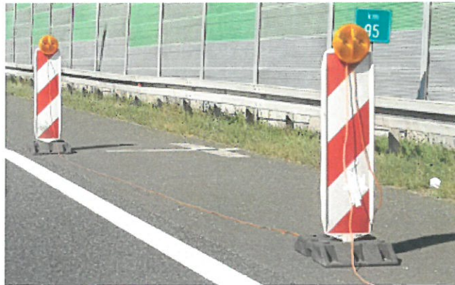
Slika 37. Primjer postavljanja svjetlosnog znaka K32 na 95. kilometru autoceste A4
