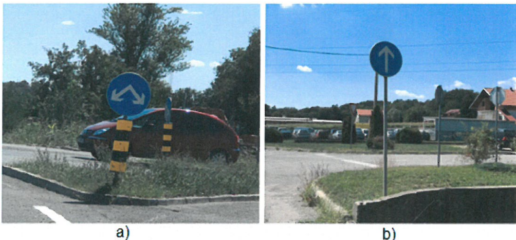
Slika 11. Primjer postavljanja znakova izričite naredbe na D3: a) znak B61 na raskrižju D3 i ceste u smjeru Seseveta, b) znak B50 u naselju Donja Zelina
