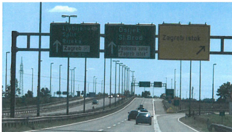
Slika 32. Primjer postavljanja znakova obavijesti za vođenje prometa D13 i D14 na raskrižju Zagreb istok
