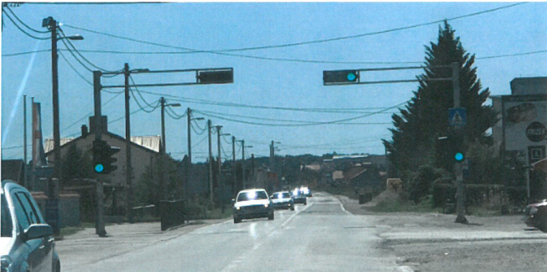
Slika 17. Primjer postavljanja svjetlosnog znaka za upravljanje prometom na D3
