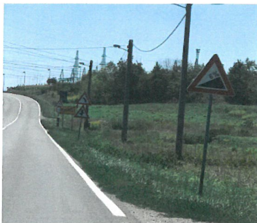
Slika 10. Primjer postavljanja znakova opasnosti A08, A03 i A13 na državnoj cesti D3 u naselju Belovar
