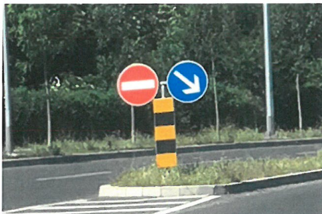
Slika 52. Primjer postavljanja ploče za označavanje prometnog otoka K06 u Ulici Siniše Glavaševića
