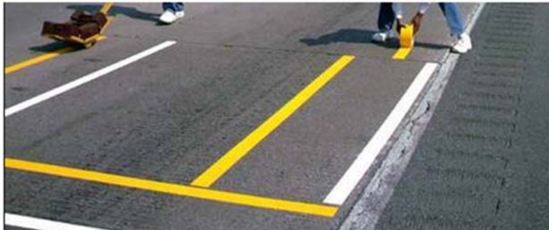
Slika 30. Oznake na kolniku izrađene trakom
