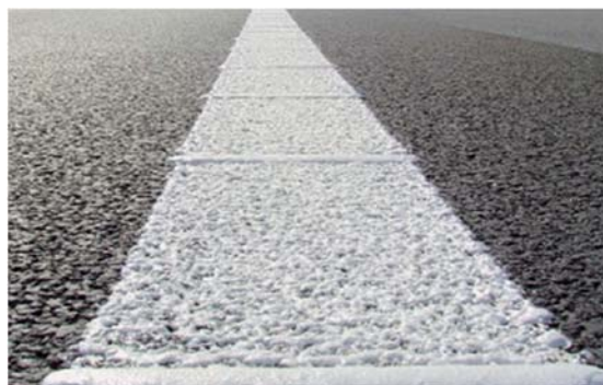
Slika 29. Oznaka na kolniku izrađena hladnom plastikom
