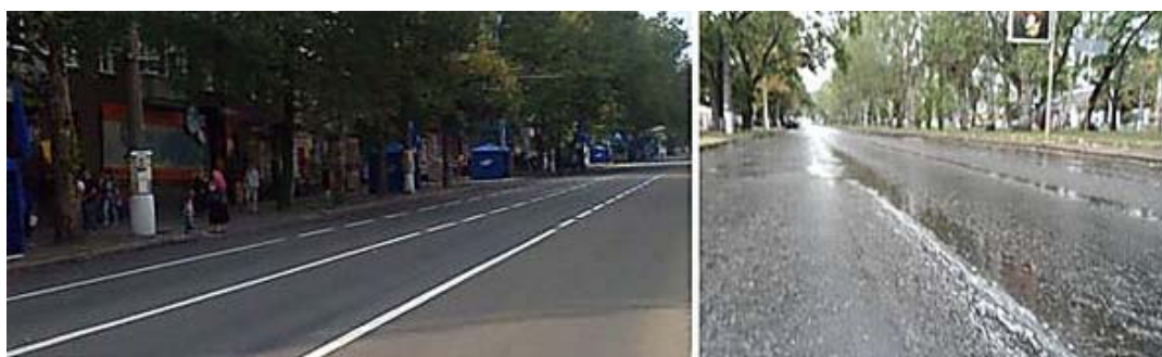
Slika 31. Usporedba vidljivosti oznaka na suhom i mokrom kolniku
