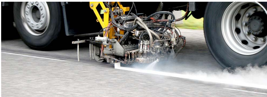
Slika 27. Nanošenje oznaka na kolnik izrađenih bojom
